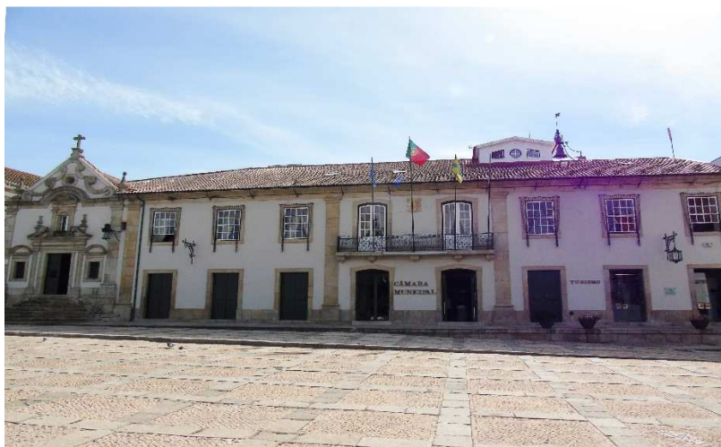
Figura 14 - Edifício dos Paços do Concelho
