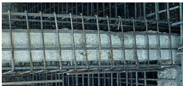
Figura 2.13: Encamisamento por betão armado em pilar (imagem rotacionada) (Faustino, 2012)
