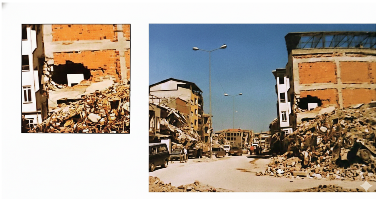
Figura 2.6: Pilar danificado pela colisão da laje do edifício adjacente (Lopes, 2008)
