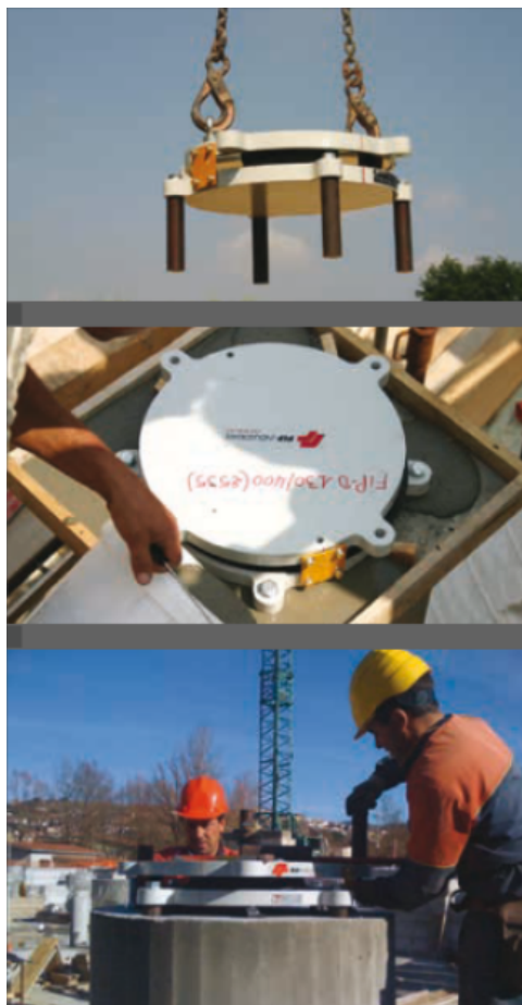
Figura 5.18: Procedimento de instalação de um aparelho FIP-D (FIP, 2016)
