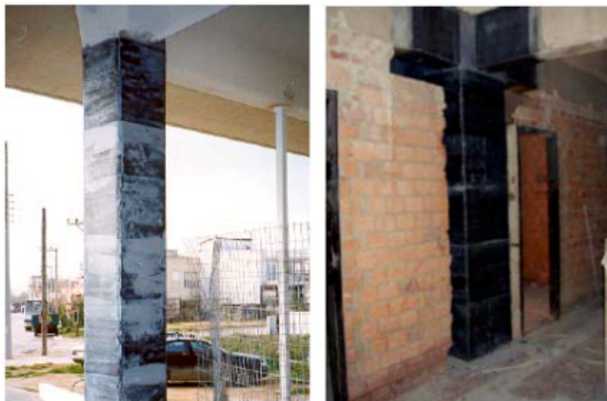
Figura 2.14: Reforço com FRP (CRC Construction Inovation, 2002)
