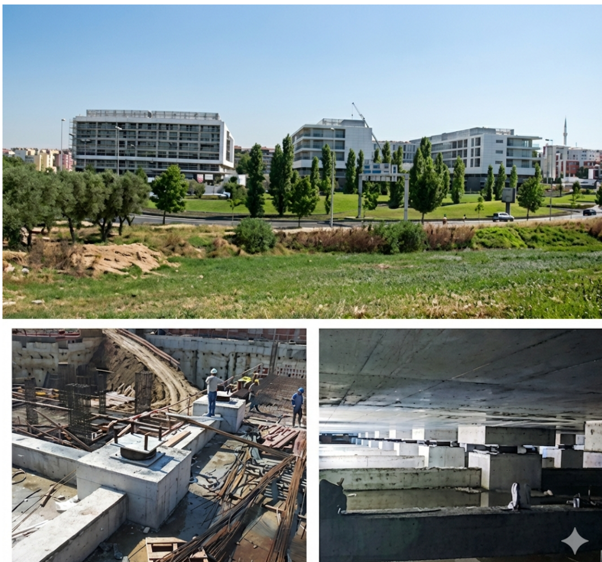
Figura 3.8: Hospital Luz - Fase de construção (Guerreiro, 2023 - Construção Magazine nº 113, pg. 14)
