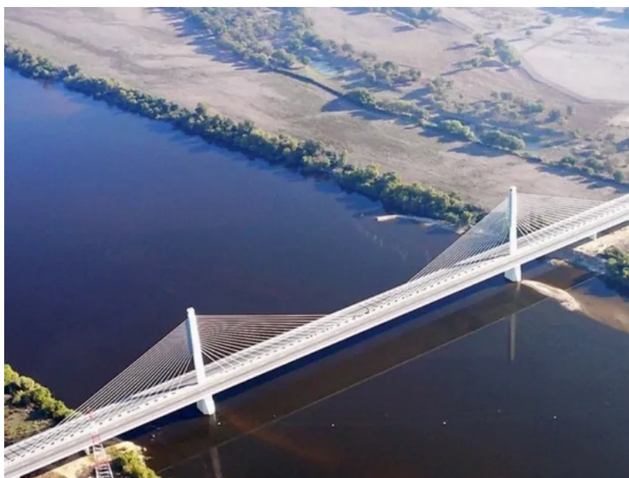
Figura 3.13: Ponte Salgueiro da Maia (Nascer do Sol, 2026)
