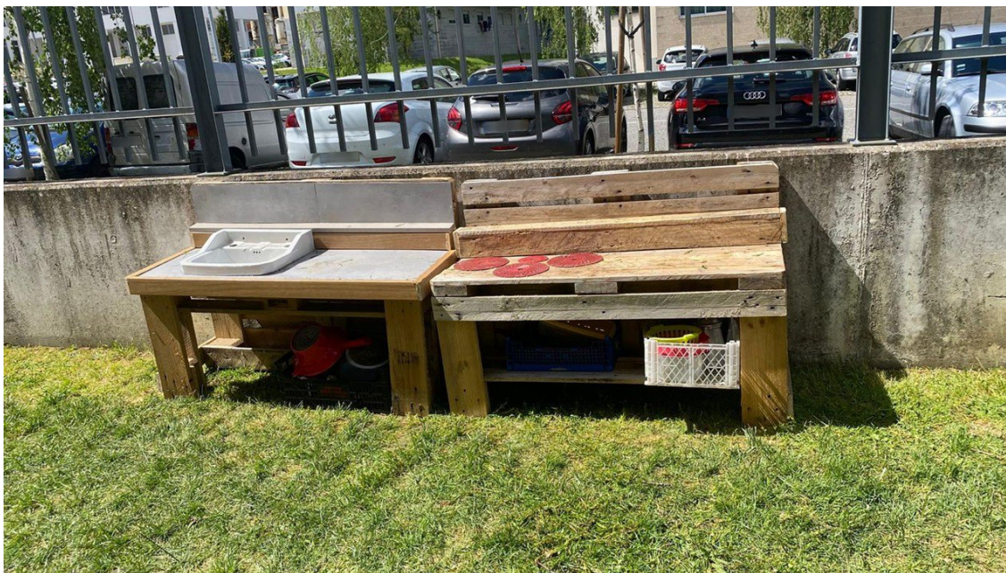
Figura 10. Construção da cozinha de lama
