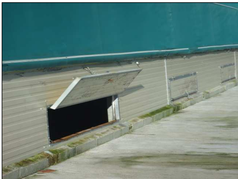
Figura 3.- Plano pormenor de uma abertura para saída dos frangos para o parque exterior. A impermeabilização (com betão) do espaço exterior envolvente contribui para uma limpeza mais eficaz e reduz muito a “importação” de terra e lama para o interior do pavilhão.
