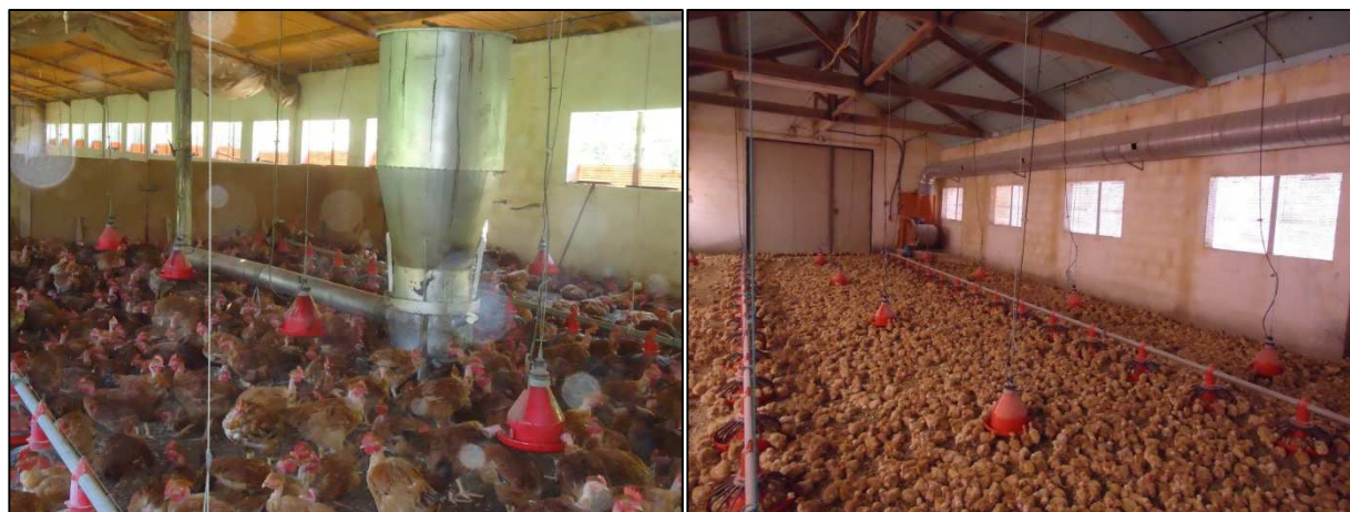
. Figura 12 - Sistema de aquecimento passivo por queima de biomassa (à esquerda). Sistema de aquecimento ativo por queima de biodiesel (à direita).
