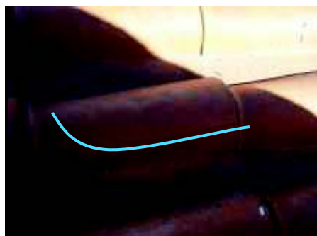
Telha fissurada
