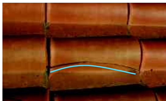
Telha fraturada
