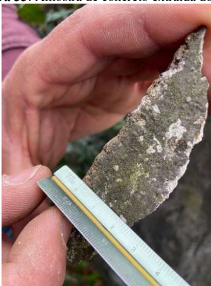
Figura 33: Amostra de concreto extraída do muro
