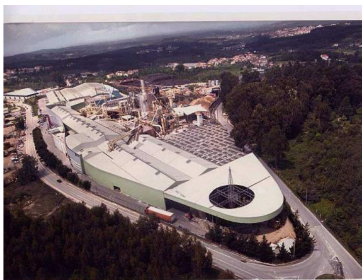
Figura 1 – Foto aérea da Sona Industria, Unidade industrial em Oliveira do Hospital.
