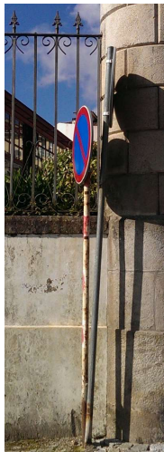
Figura 84 - Sinalização com diferentes alturas de colocação
