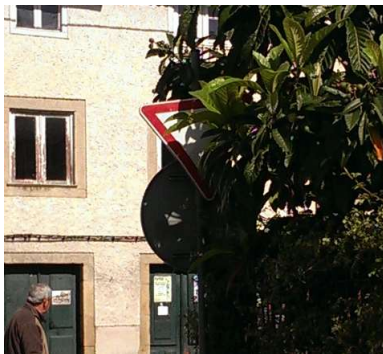
Figura 83 - Limpeza de Sinalização
