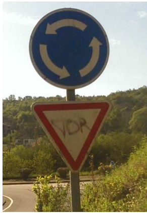
Figura 99 - Sinalização a necessitar de limpeza
