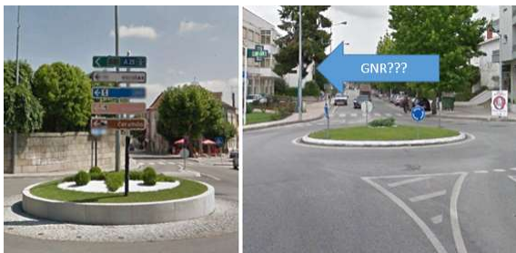
Figura 6 - Inexistência de continuidade de sinalização
