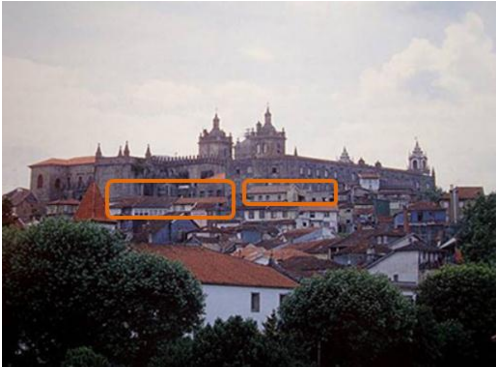
Figura 5-42: Vista de parte do edificado, localizado na parte Este do centro histórico de Viseu. Adaptado de (Cabrita et al , 2010b, cap. 1, 6)
