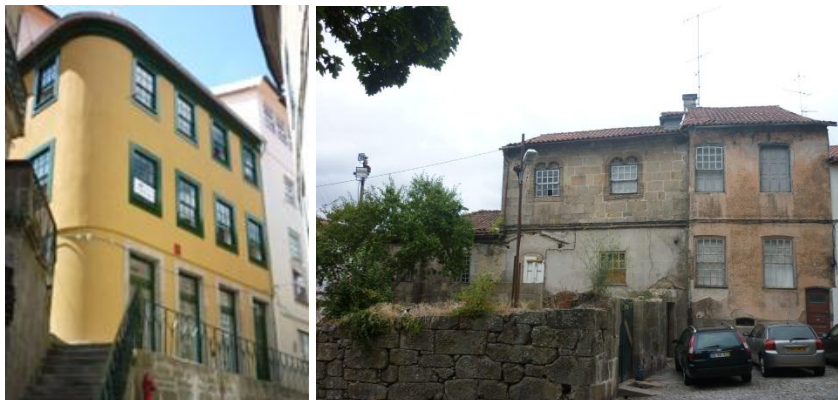
Figura 6-22: Edifício 2 e 13 (da esquerda para a direita)
