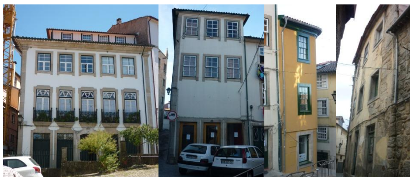
Figura 5-19: Edifício totalmente ocupado, parcialmente ocupado, devoluto e em ruína, da esq. para a dir., respetivamente
