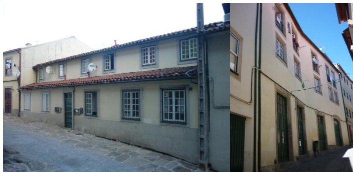
Figura 5-25: Edifício em que a fachada à vista virada para a Rua Trás do Colégio tem 2 pisos (à esq.) e a virada para a Rua Escura possui 4 pisos (à dir.)
