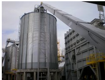
Figura 4: Silo de Armazenamento (Fotografia captada na empresa Pinewells -Arganil).
