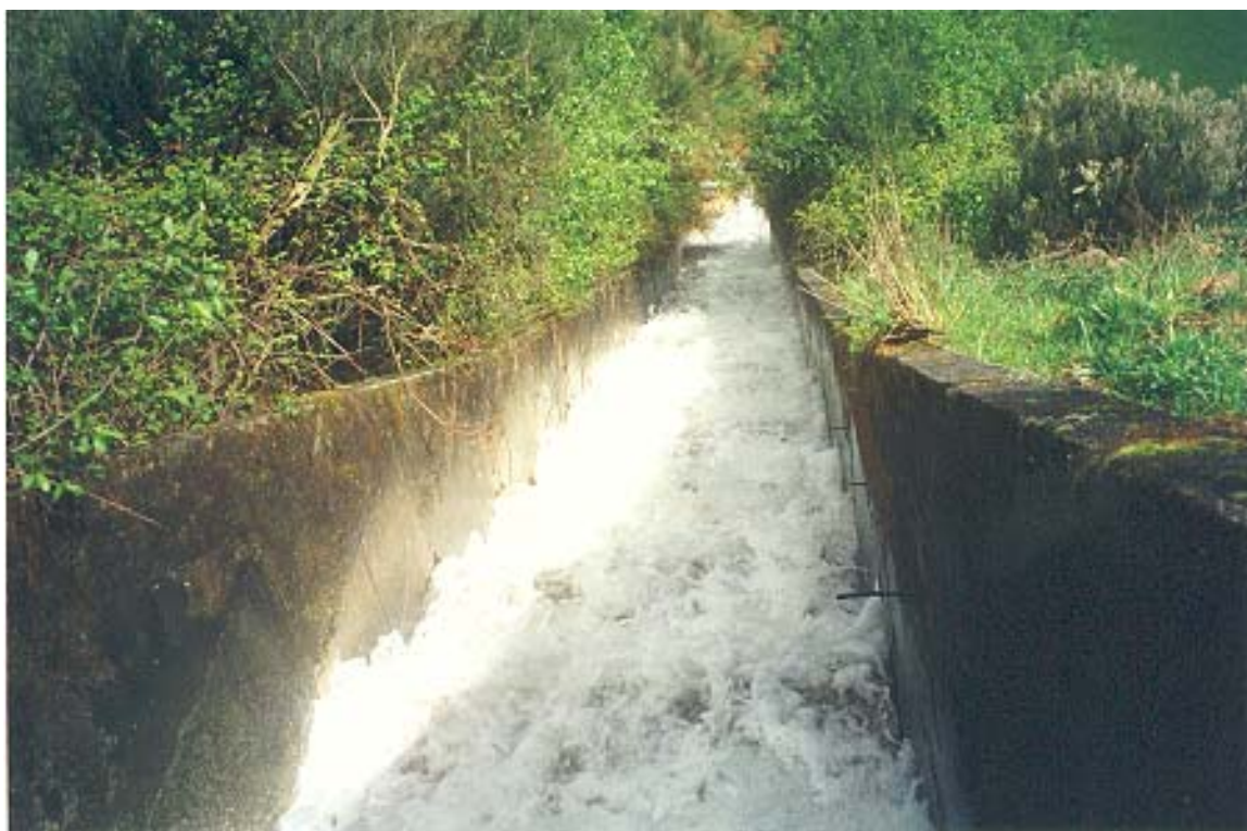
Figura C 16– Escoamento em quedas sucessivas ( nape flow ) num canal com soleira em degraus a jusante de um aqueduto.
