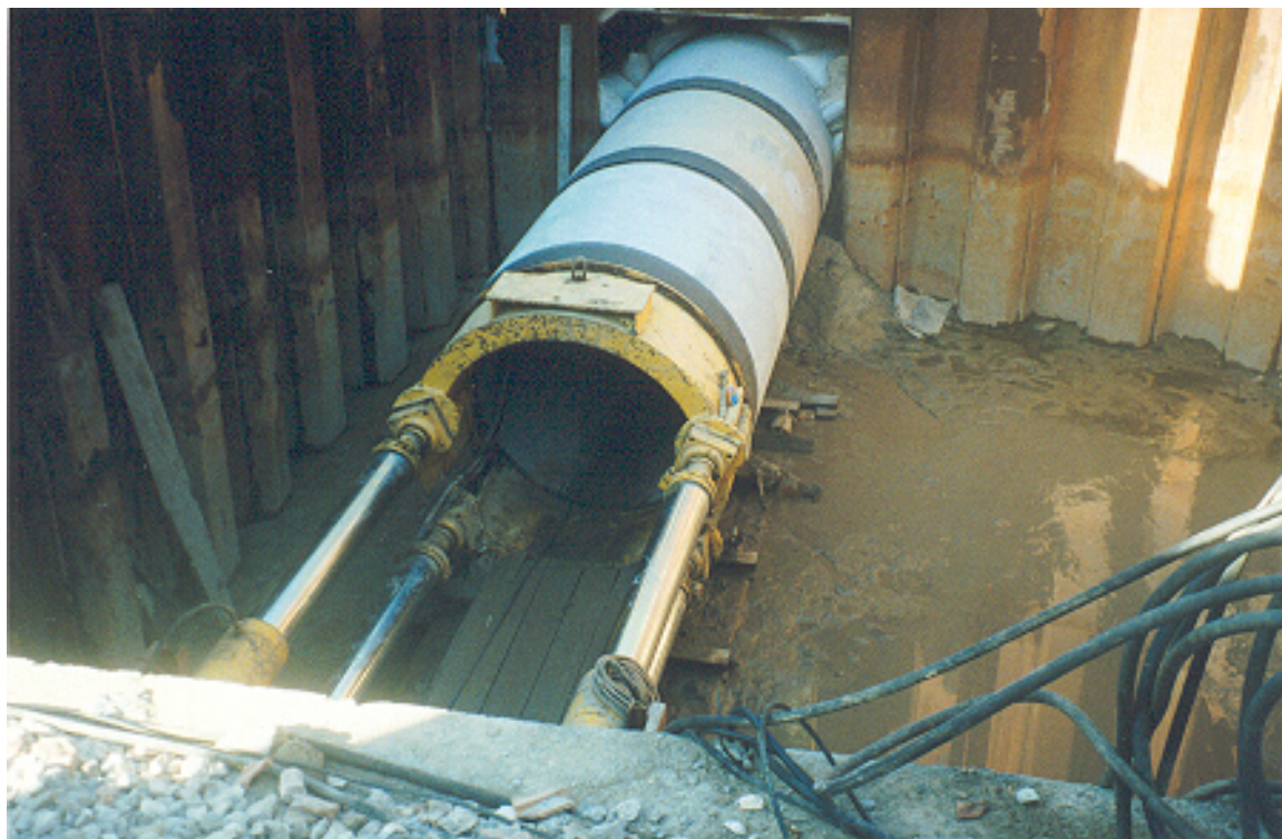
Figura C7 – Execução de um aqueduto de secção circular com macacos hidráulicos.
