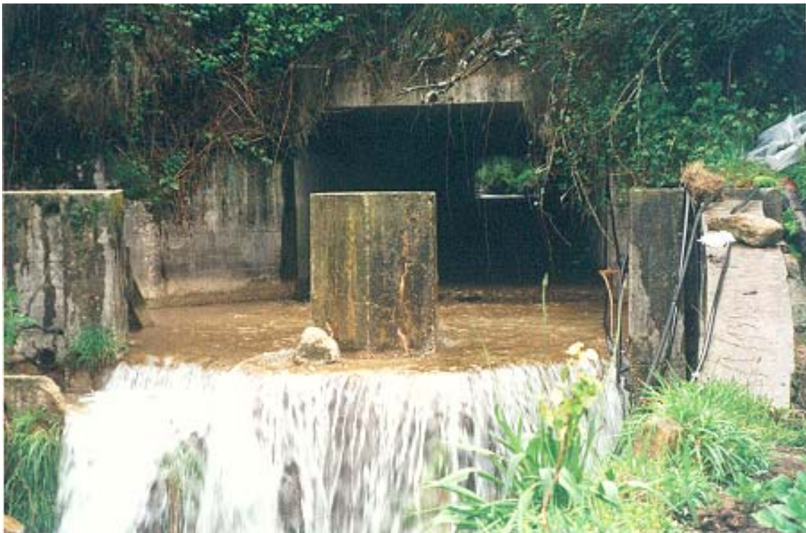
Figura C4 – Aqueduto de secção rectangular.
