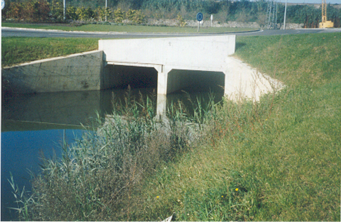
Figura C5 – Aqueduto duplo de secção rectangular.
