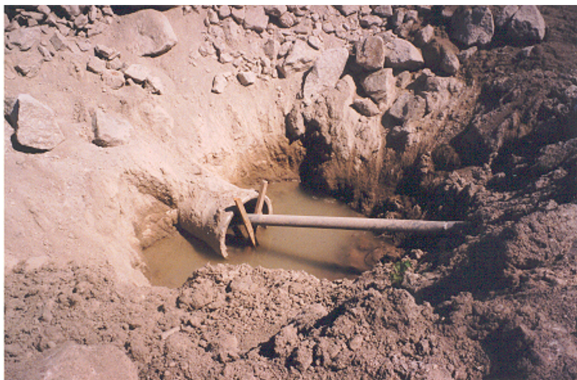
Figura C8 – Construção de aqueduto de secção circular.
