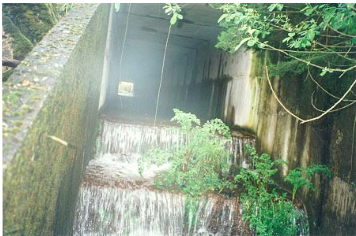
Figura C 15 – Canal com soleira em degraus a jusante de um aqueduto de secção rectangular.
