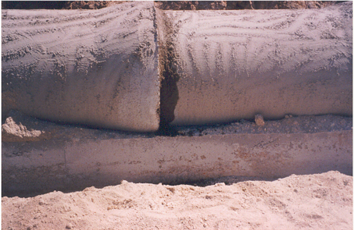
Figura C9 – Aqueduto de secção circular com assentamento em betão.
