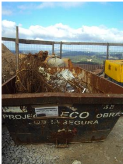
Armazenamento de ferro e metais no estaleiro
