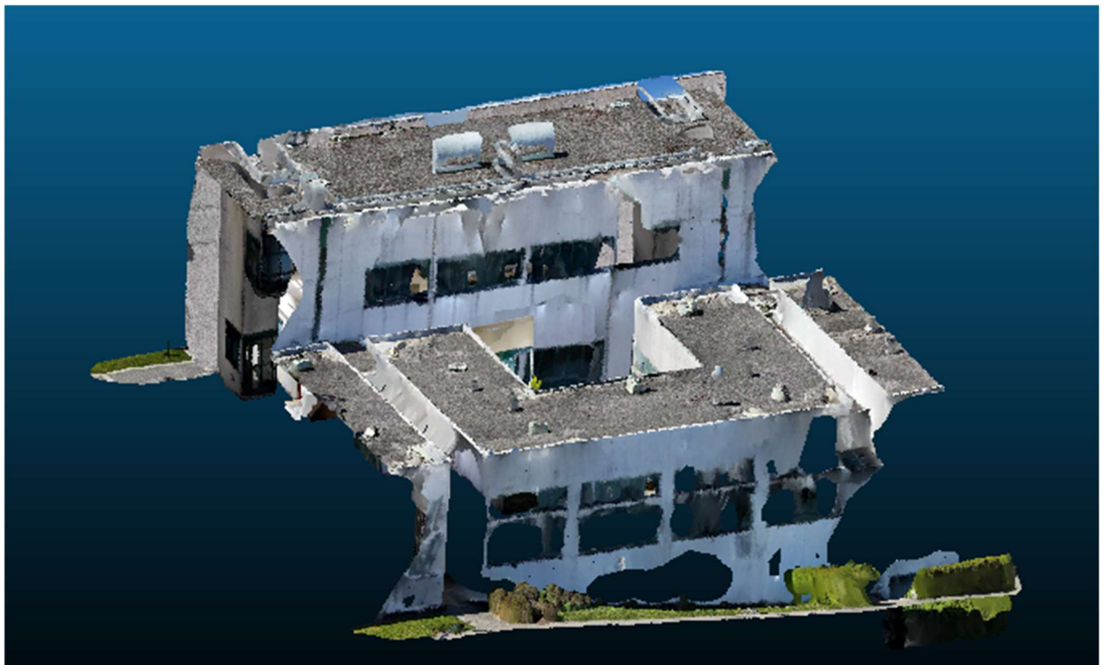
Figura 39 - Nuvem de pontos no CloudCompare - Externa (Fachada posterior)
