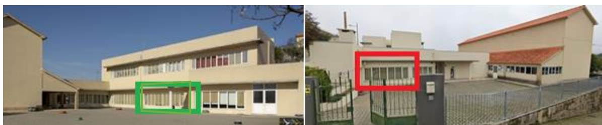
Figura 15 – Armamar - Jardim de Infância de Armamar. O polígono verde indica a localização da Sala 1, e o polígono vermelho indica a localização da Sala 2.
