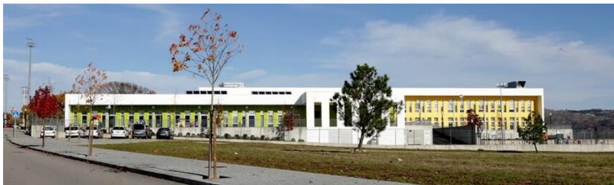
Figura 66 – Moimenta da Beira – Centro Escolar.
