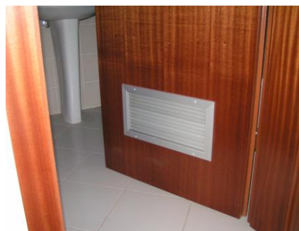
d) Grelha instalada na porta da instalação sanitária e cozinha.
