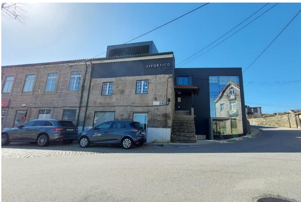
Figura 19 - Fachada externa do edifício
