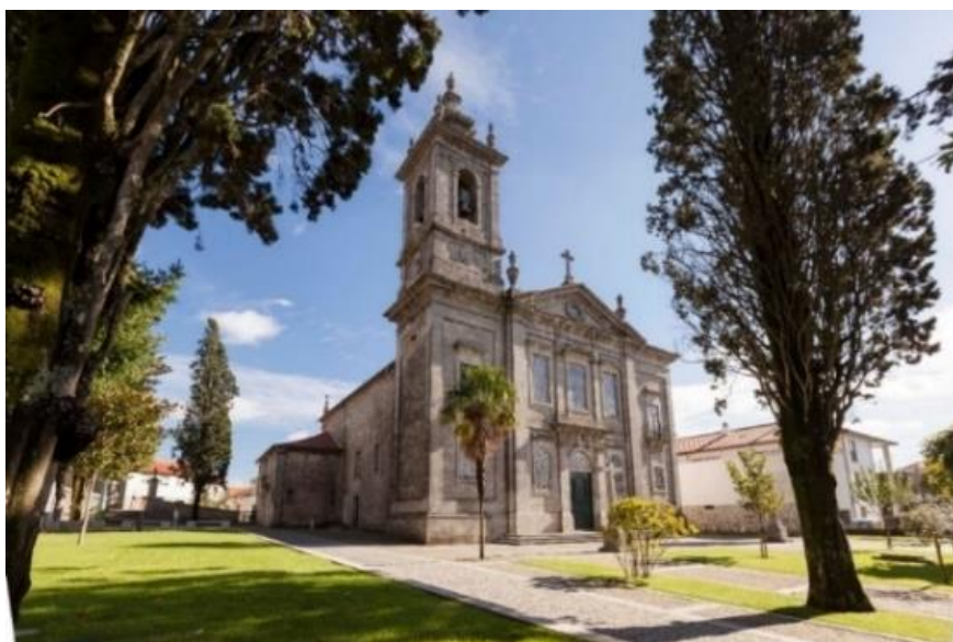
Figura 5 – Igreja Matriz de Castro Daire
