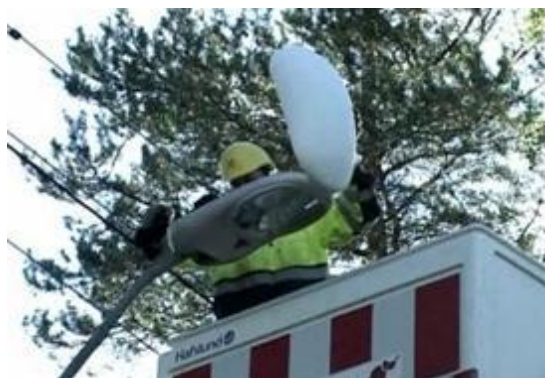
Figura 2.28 – AÇão de manutenÇão de uma luminária [15].
