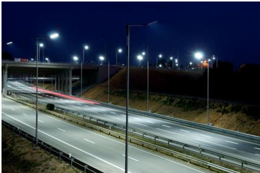
Figura 3.41 – Solução de iluminação utilizada na A29, nó de Angeja, km 1 [40].
