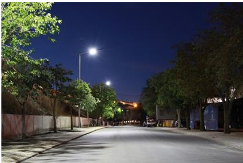
Figura 3.42 – Luminárias a LED instaladas na Rua Fidalgo Aprendiz, Pombal [41].
