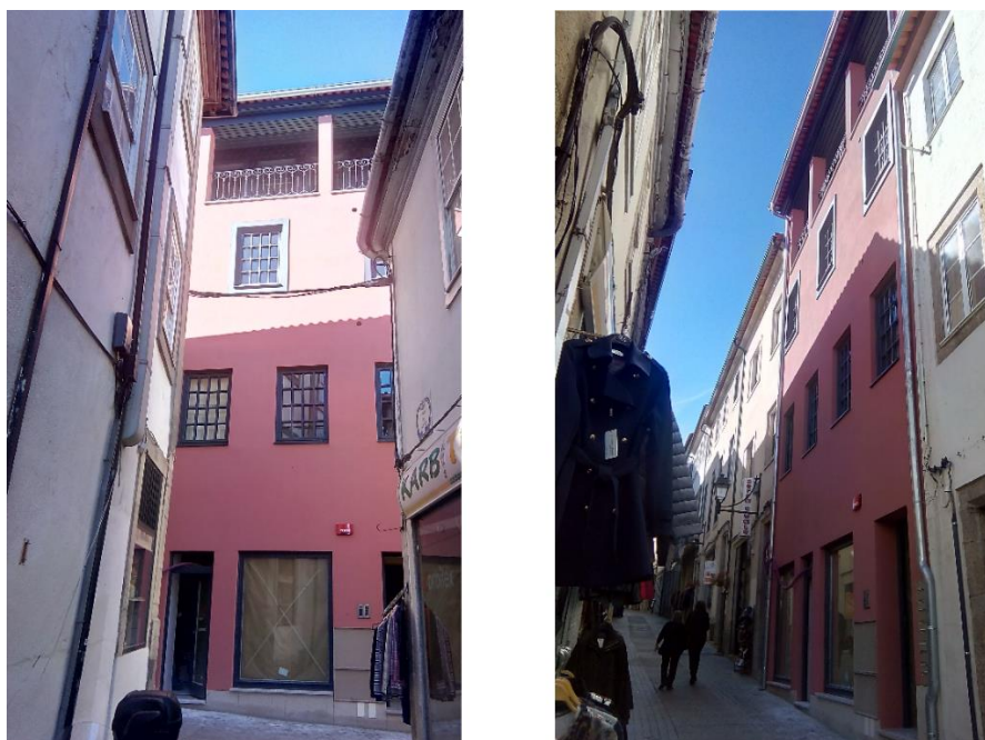
Figura 4-13: Alçado principal do edifício 2 em estudo (corpo principal do edifício) – situação após intervenção de reabilitação
