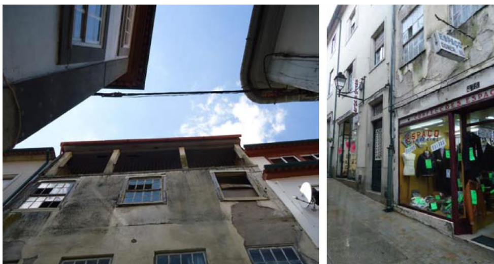
Figura 4-12: Alçado principal do edifício 2 em estudo (corpo principal do edifício) – situação preexistente (Fonte: Viseu Novo)
