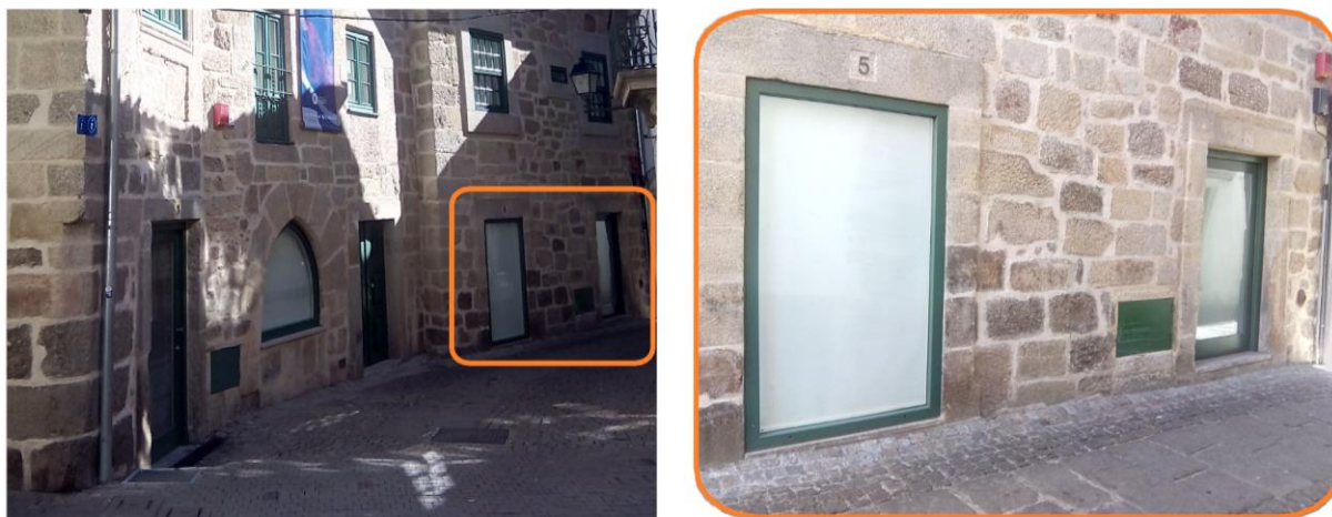
Figura 4-18: Identificação da porta de acesso à cafeteria do edifício 3 em estudo
