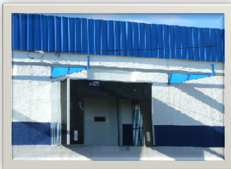
Figura 46 - Cais de receção
