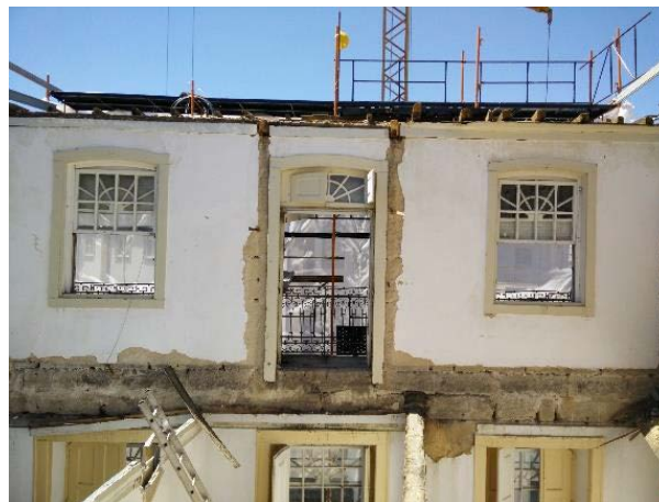
Figura 20: Parede exterior do Ed.3 em alvenaria de pedra (Fernandes C., 2016)
