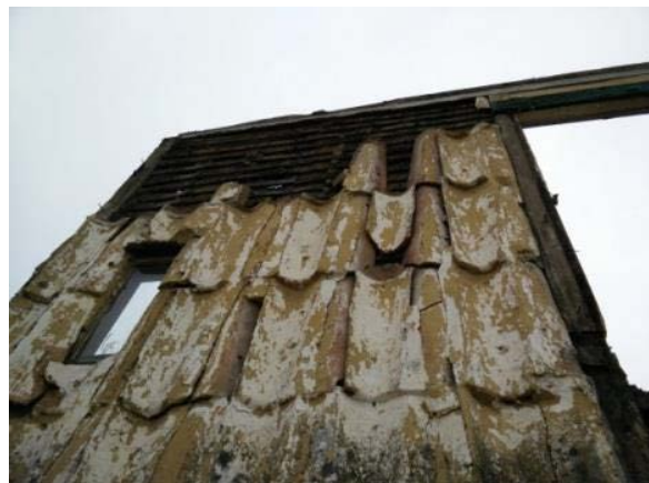
Figura 14: Utilização de telha cerâmica como revestimento exterior de uma parede de tabique do Ed.1 (Fernandes C., 2016)
