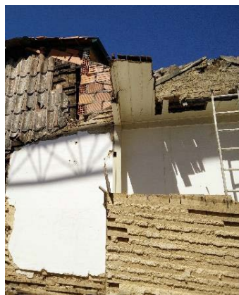
Figura 21: Parede exterior do Ed.3 em tabique (Fernandes C., 2016)
