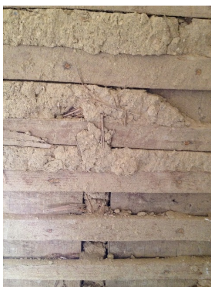
Figura 18: Parede de tabique preenchida e revestida integralmente com argamassa de terra e palha do Ed.2
