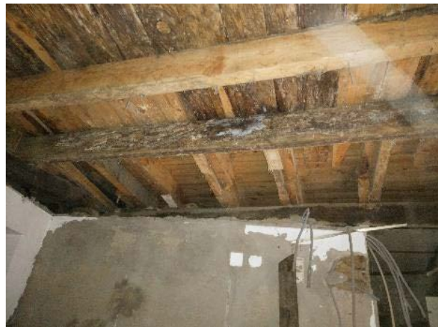
Figura 13: Pavimento em madeira maciça do Ed.1 (Fernandes C., 2016)
