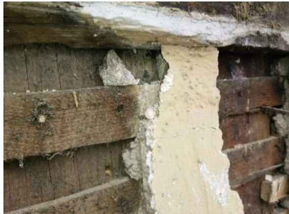
Figura 15: Revestimento de argamassa de cimento do Ed.1 (Fernandes C., 2016)
