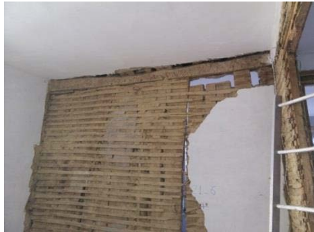
Figura 12: Parede interior de tabique do Ed.1 (Fernandes C., 2016)
