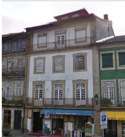
Figura 19: Fachada principal do Ed.3 (Fernandes C., 2016)
