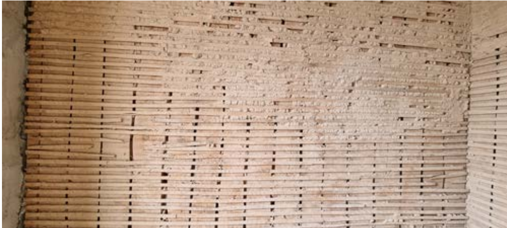
Figura 5: Exemplo de uma parede de tabique de um edifício situado em Viseu
