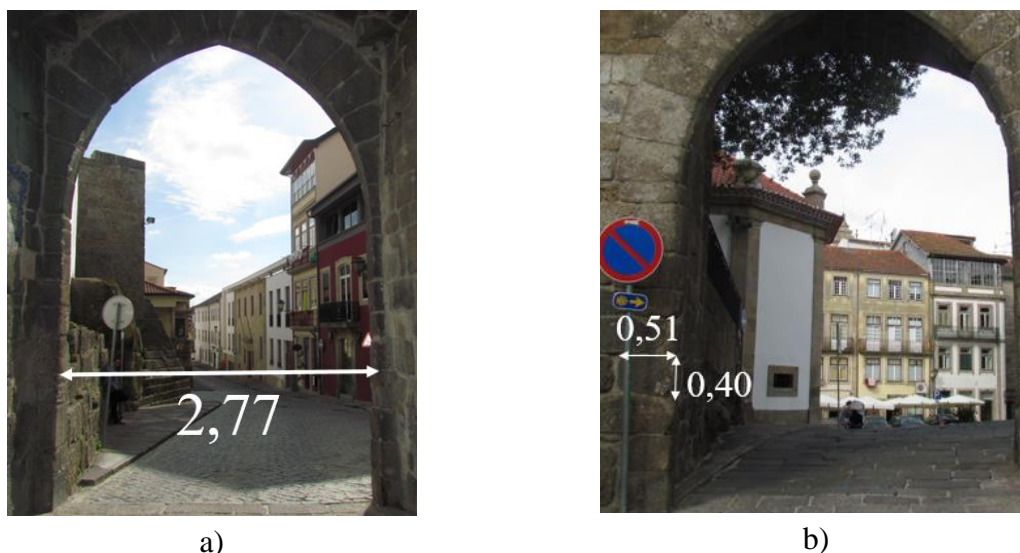
Figura 6-15: Medidas obtidas, em metros, com fita métrica: a) largura do arco para escala e b) medidas de uma das pedras do lado da Rua Nunes Carvalho para comparação com método fotogramétrico
