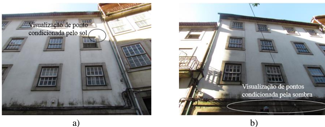
Figura 3-1 Exemplo de fotografias com visualização de pontos condicionada por: a) sol e b) sombras.
