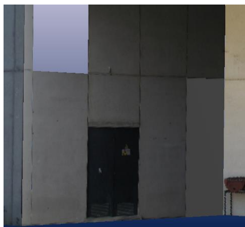
Figura 5-28: Correção resultante do erro causado por grelhador no local
