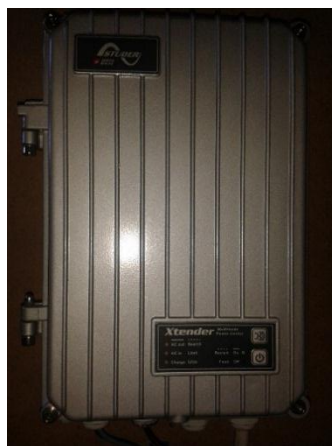
Figura 3-19: Inversor monofásico XTS1200-24.
