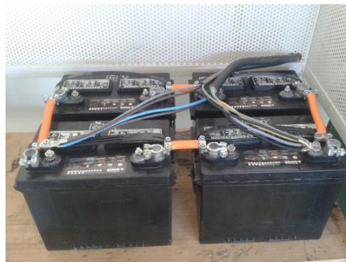
Figura 3-13: Banco de baterias do sistema híbrido autónomo.
