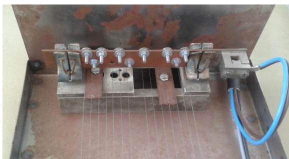
Figura 3-18: Isolamento e fixação dos fios da carga de dissipação.
