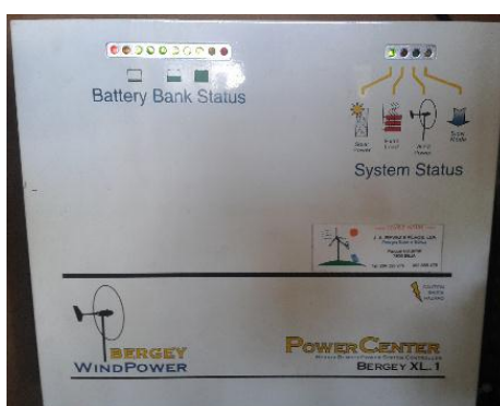
Figura 3-3: Unidade de controlo da turbina ( Power Center ).
