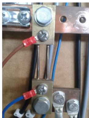
Figura 3-31: Resistência shunt.
