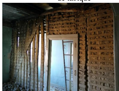
d) Abertura em parede de tabique
