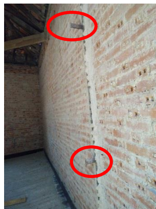
b) Alvenaria de tijolo e chapas metálicas
