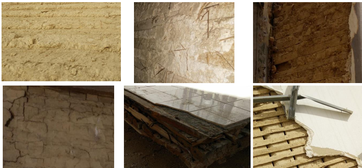
Figura 2-30: Diferentes tipos de revestimento utilizados nas paredes interiores de tabique do Ed.3
