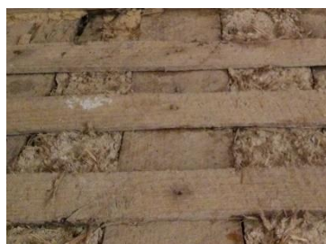
a) Paredes de tabique revestidas integralmente com argamassa de terra e palha
