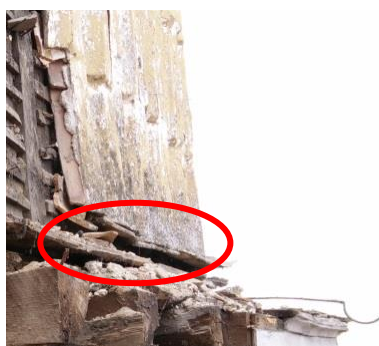
a) Telhas colocadas perpendicularmente
