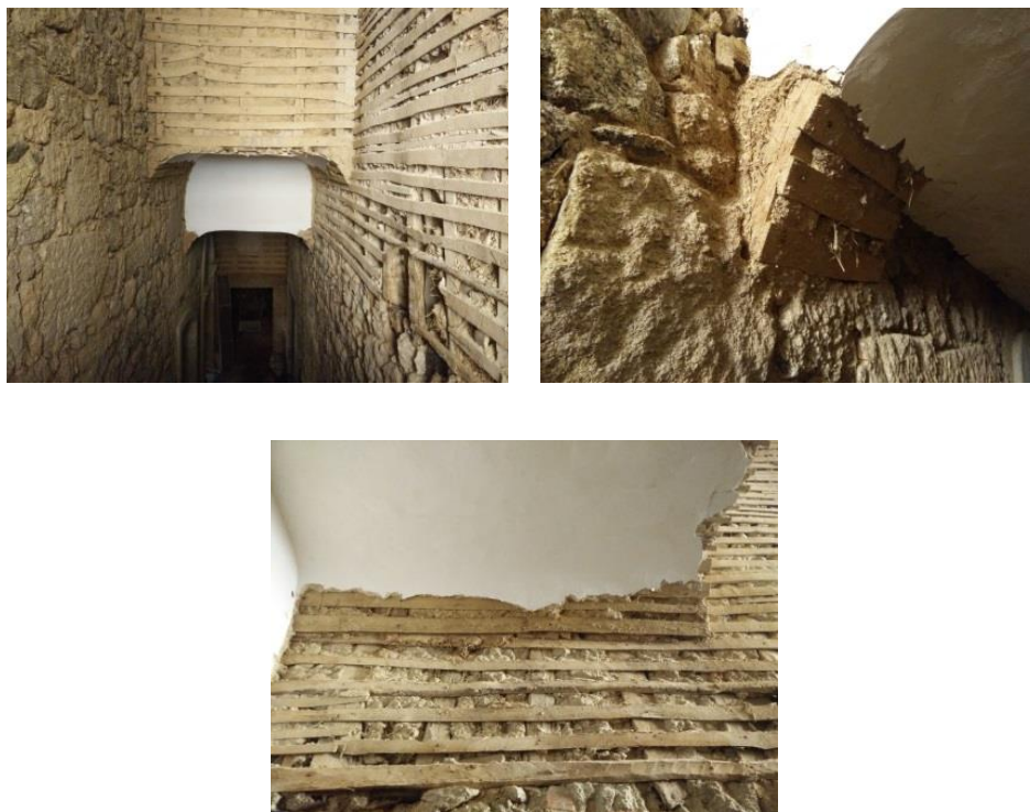
Figura 2-41: Pormenores do teto da caixa de escadas em tabique
