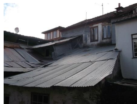
c) Fachada Posterior do Ed.2 antes da demolição
