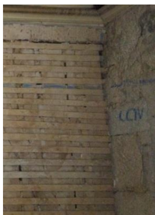
a) Encontro alvenaria-tabique
