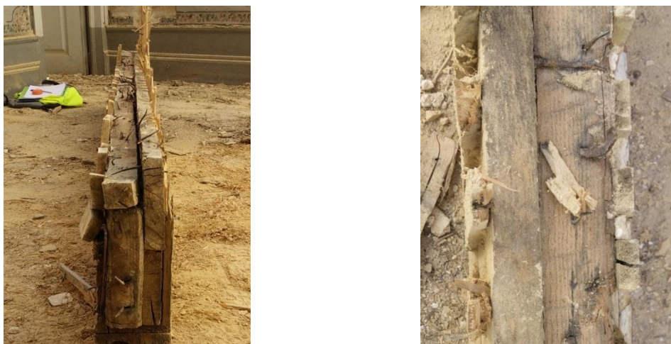
Figura 3-3: Pregagem entre fiadas e entre tábuas verticais da mesma fiada
