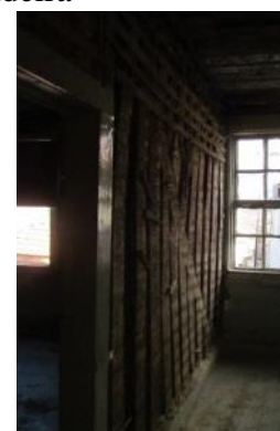
e) Deformação do tabique
