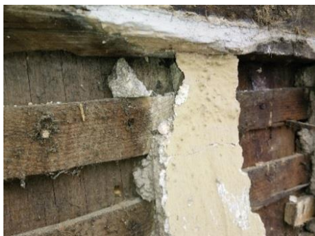
Figura 2-11: Argamassa de cimento existente no alçado posterior
