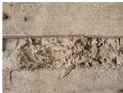
b) Revestimento do tabique de idade intermédia
