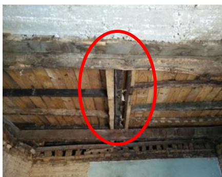
c) Pormenor do pavimento de madeira, junto ao betão
