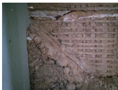
a) Pormenor ampliação através de construção de parede de tabique
