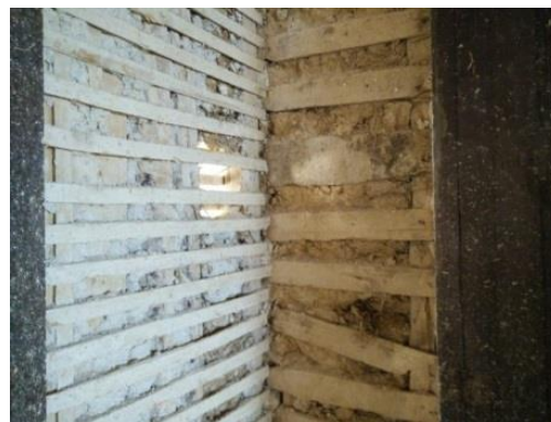
b) Encontro de duas paredes de tabique
