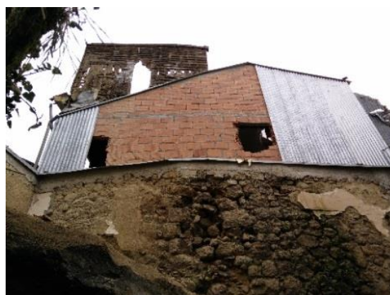
b) Aspeto geral da parede meeira
