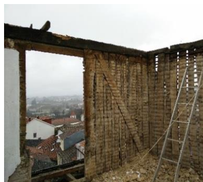
b) Parede de tabique exterior com frechal em castanho
