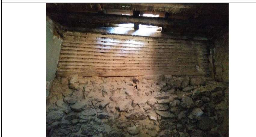
Figura 3-13: Ligações inferiores entre tabique e alvenaria – Caso 3
