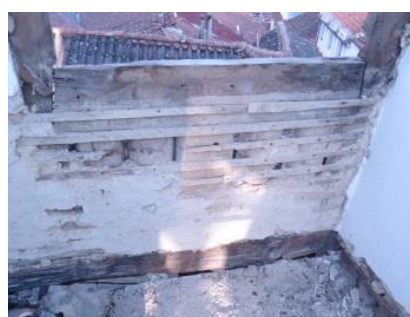
b) Pormenor janela em parede de tabique
