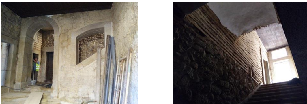
Figura 2-35: Paredes interiores de alvenaria de pedra
