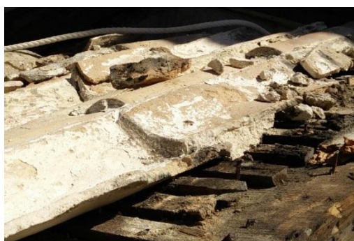
Figura 2-29: Telha e argamassa utilizadas como revestimento exterior
