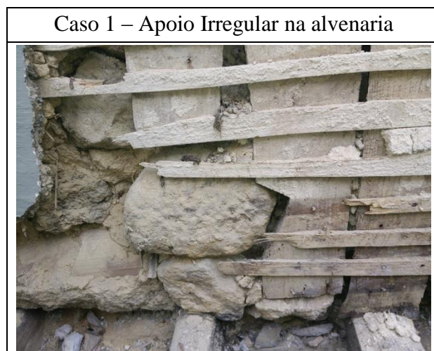
Figura 3-11: Ligações inferiores entre tabique e alvenaria – Caso 1
