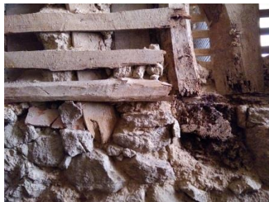
b) Transição alvenaria-tabique (Caixa de escadas)
