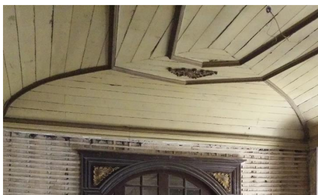
Figura 2-40: Revestimento do teto em ripado de madeira
