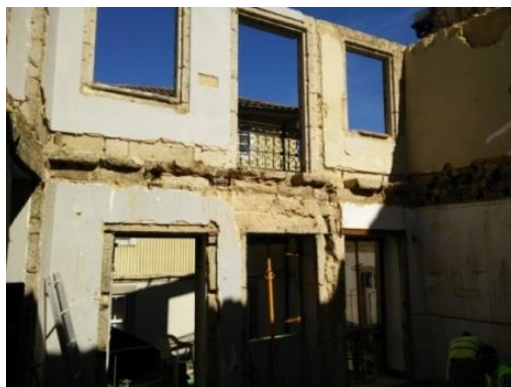
Figura 2-5: Alvenaria dos pisos 0 e 1 (Alçado Lateral Esquerdo)
