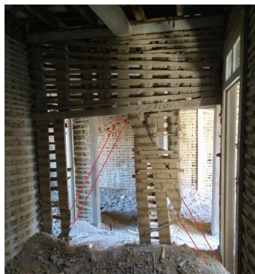
Caso 9 – Diagonais em ‘V’ invertido (desenvolvimento vertical inferior ao pé direito)
