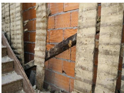
Figura 2-3: Pormenor Viga inclinada pertencente a estrutura de cobertura antes da ampliação
