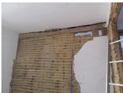
Figura 2-9: Parede interior de tabique do Ed.1
