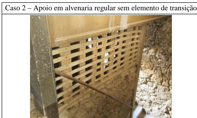
Figura 3-12: Ligações inferiores entre tabique e alvenaria – Caso 2
