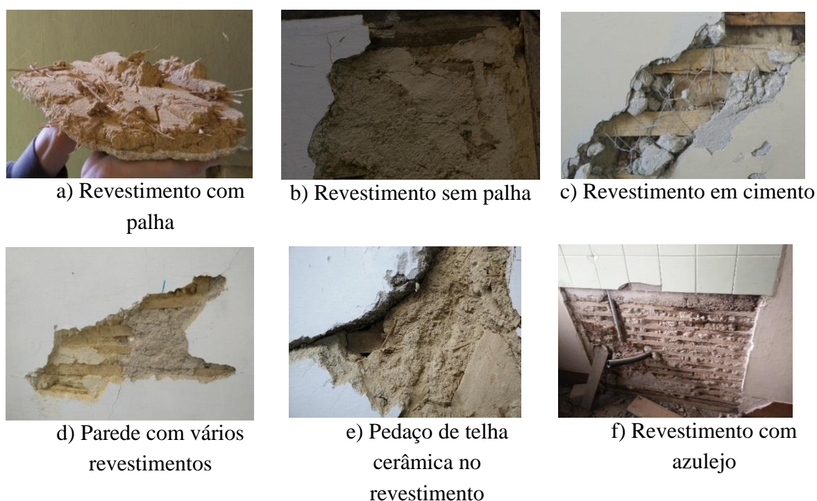
Figura 2-13: Revestimentos das paredes interiores de tabique do Ed.1
