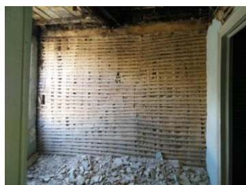
b) Paredes de tabique com enchimento em argamassa tradicional e revestimento em cimento
