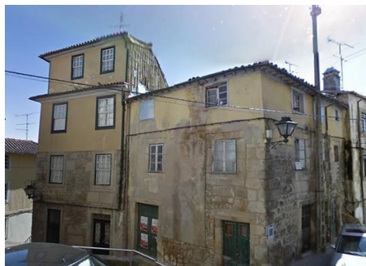
b) Fachada principal do Ed.1 (Setembro de 2009) – imagem retirada de ( https://www.google.pt/maps )
