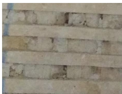
c) Revestimento do tabique mais recente
