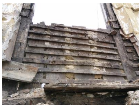
c) Pormenor janela em parede de tabique
