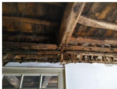
b) Viga principal apoiada sobre frechal
