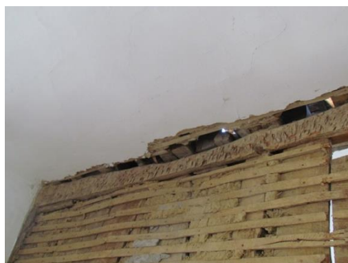
b) Frechal com faces golpeadas para melhorar aderência da argamassa
