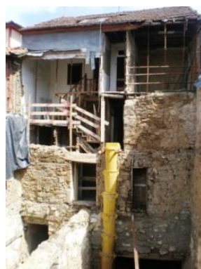
b) Fachada Posterior do Ed.2 após demolição parcial
