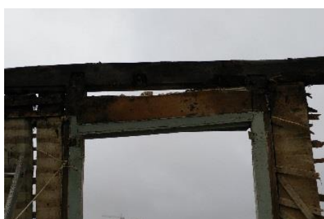
a) Pormenor janela em parede de tabique
