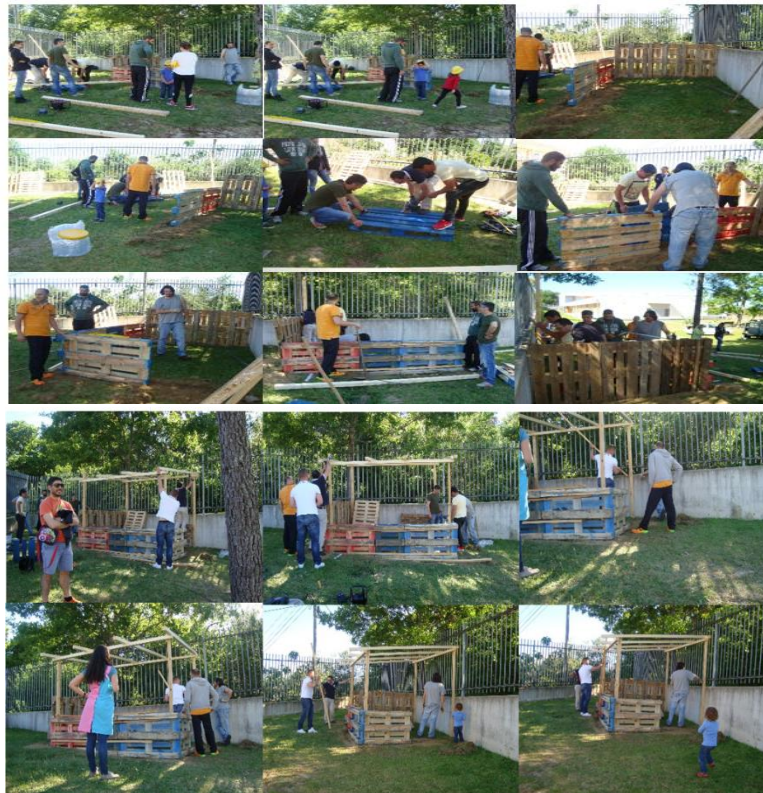
Figura 41 - Primeira fase da construção do Cozilab
