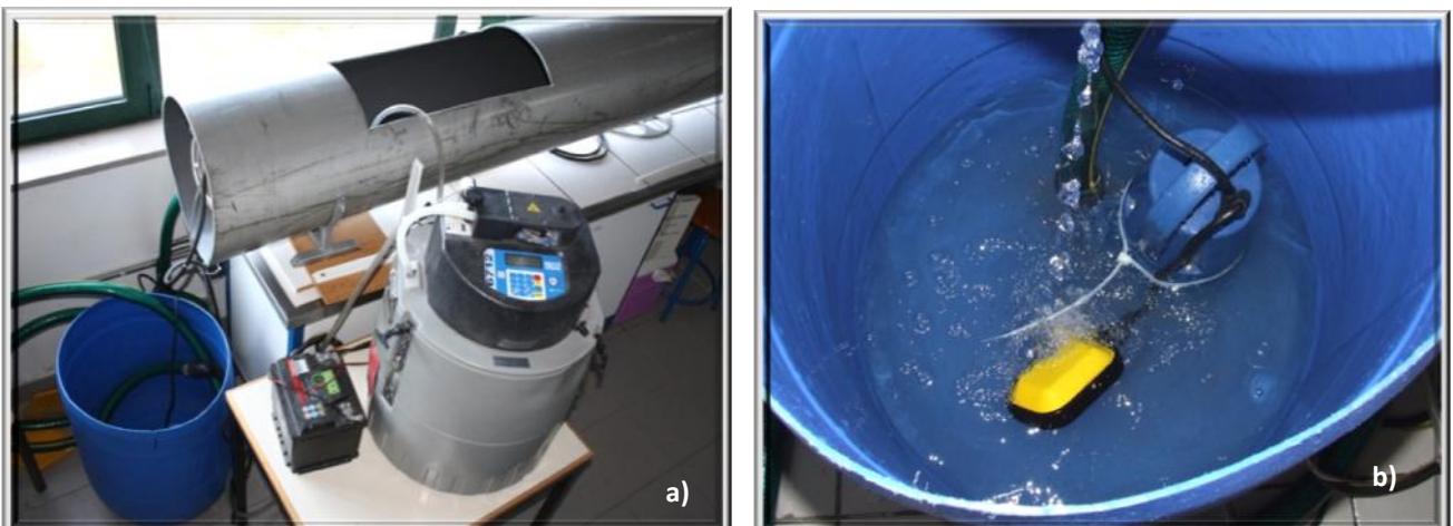
Figura 9-10 – a) Fotografia da parte final da conduta, com o depósito de receção de água. b) Fotografia do pormenor da bomba de recirculação de água, colocada no depósito que recebe a água da conduta.
