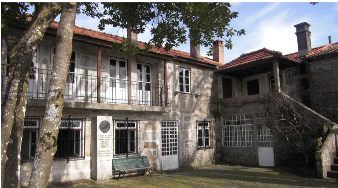
Ilustração 2 - Soutosa, atual Fundação Aquilino Ribeiro, em Moimenta da Beira
