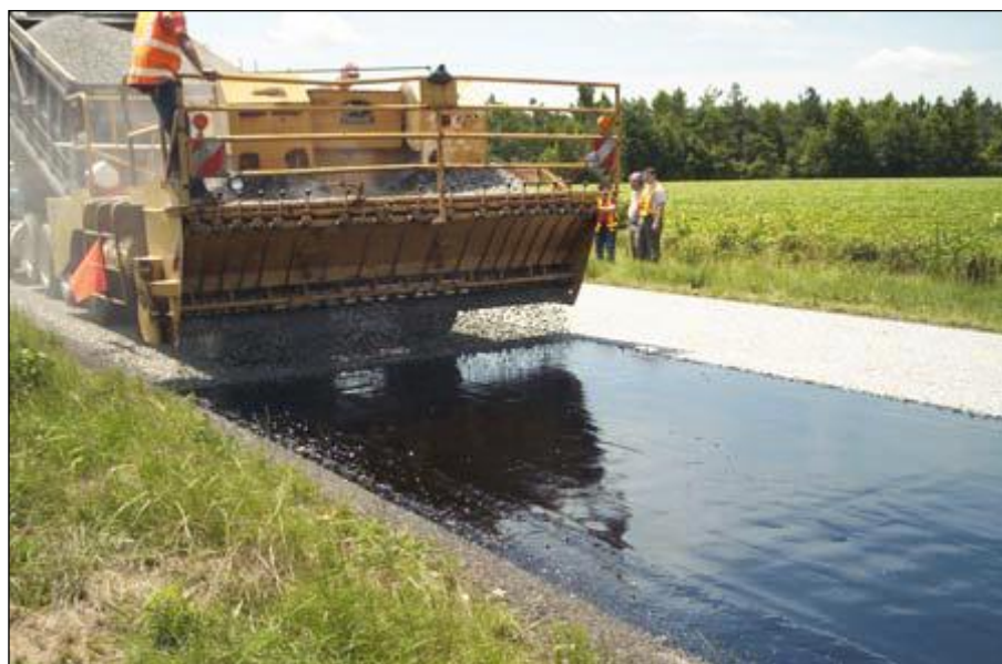
Figura 3-24: Camião distribuidor de SAMI (Clemson, 2011)
