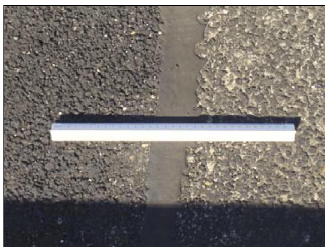
Figura C-2: Pormenor da transição entre os dois tipos de pavimento BMB e BB (Guerra et al. , 2005)
