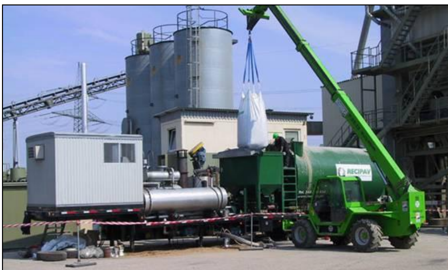
Figura 3-17: Instalação do equipamento de fabrico de BMB junto a uma central (Recipav, 2007)
