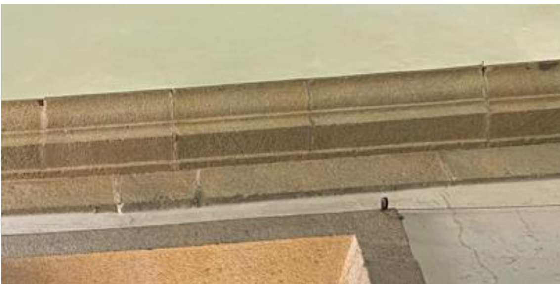
Fotografia 39 – Localização: Parede Lateral Esquerda (interna)
