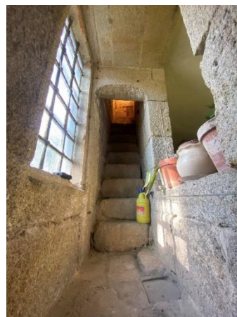
b) Patamar e segundo lanço da escada
