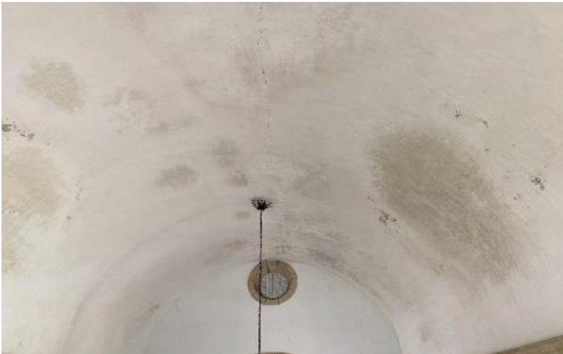
Fotografia 82 – Localização: Forro da Cobertura da Nave
