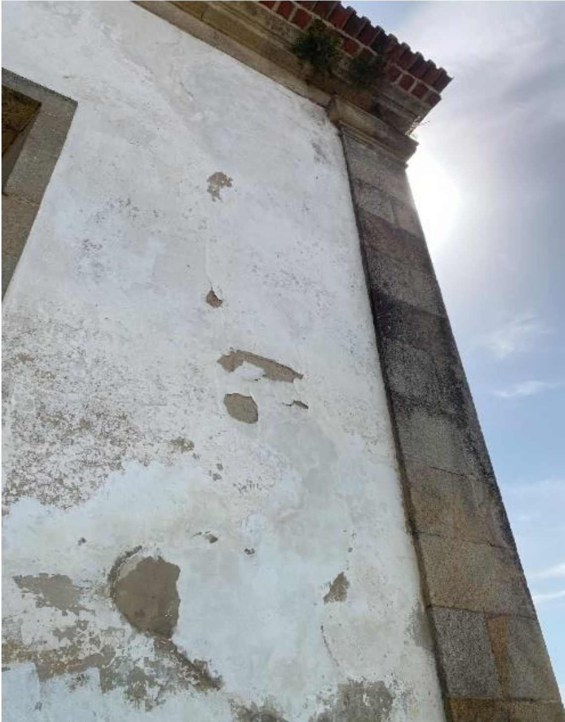
Fotografia 44 – Localização: Alçado Lateral Esquerdo
