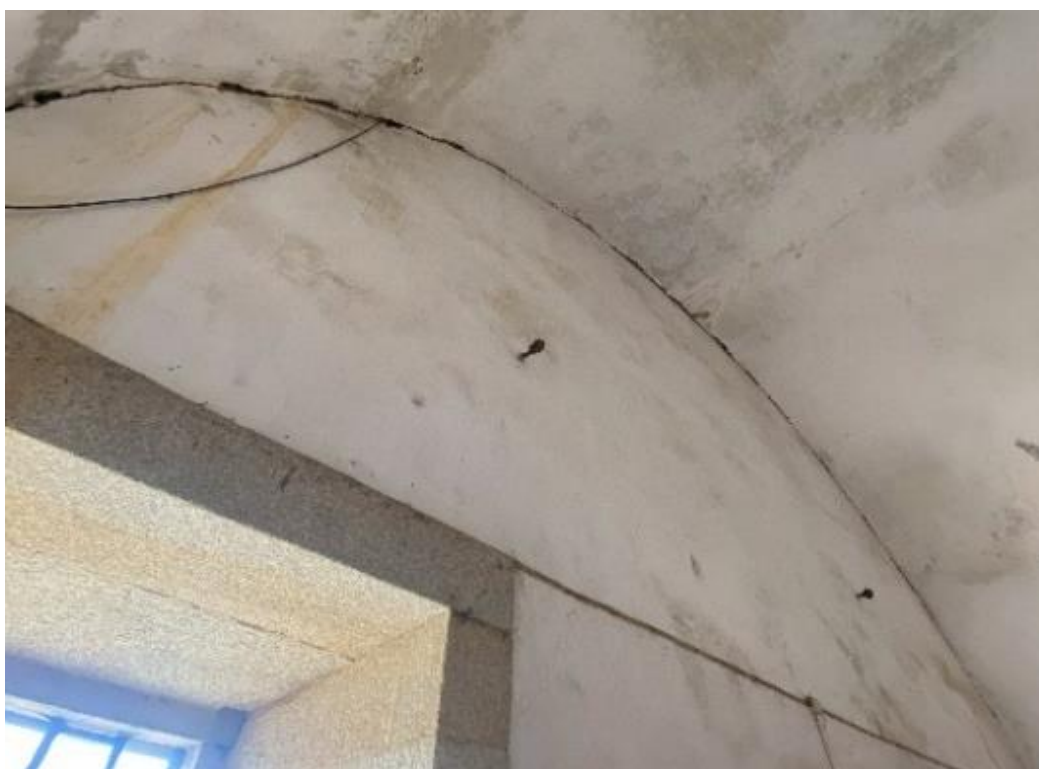
Fotografia 21 – localização: Parede Frontal (interna) por cima do Coro
