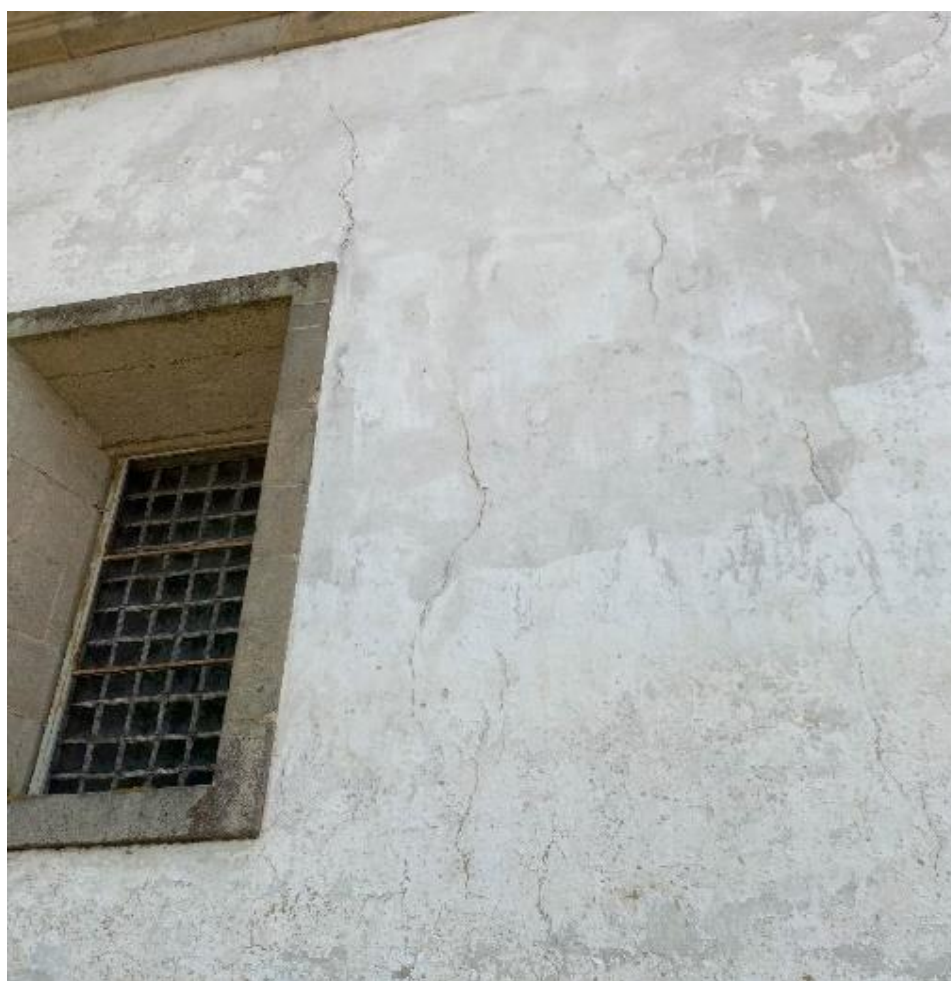
Fotografia 41 – Localização: Alçado Lateral Esquerdo
