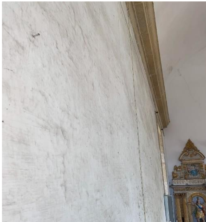
Fotografia 35 – Localização: Parede Lateral Esquerda (interna) da Nave
