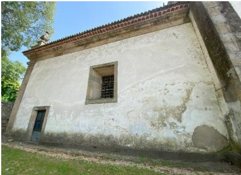
Fotografia 48 – Localização: Alçado Lateral Esquerdo
