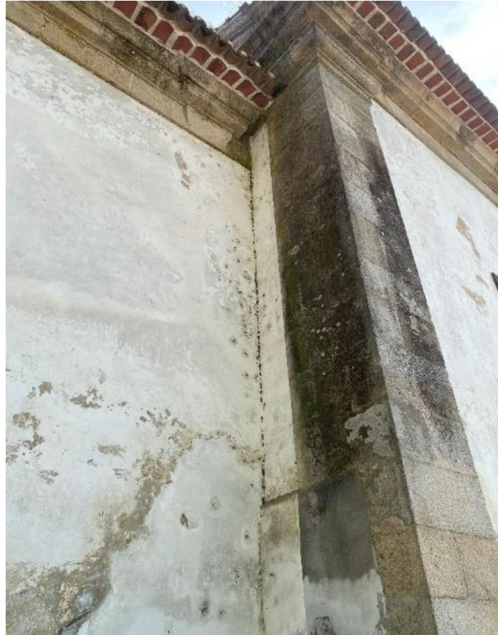
Fotografia 47 – Localização: Alçado Lateral Esquerdo
