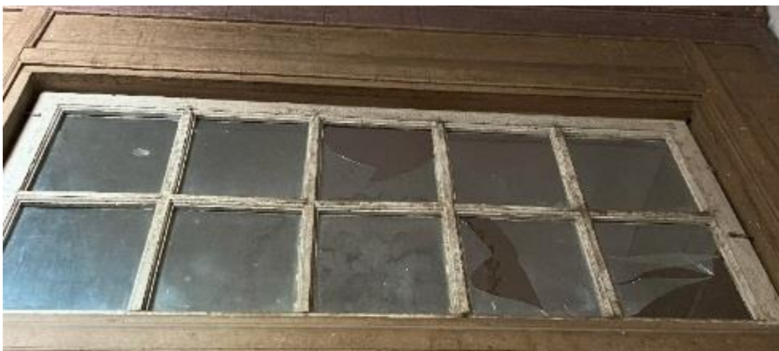
Fotografia 85 – Localização: Janela do Átrio de Entrada
