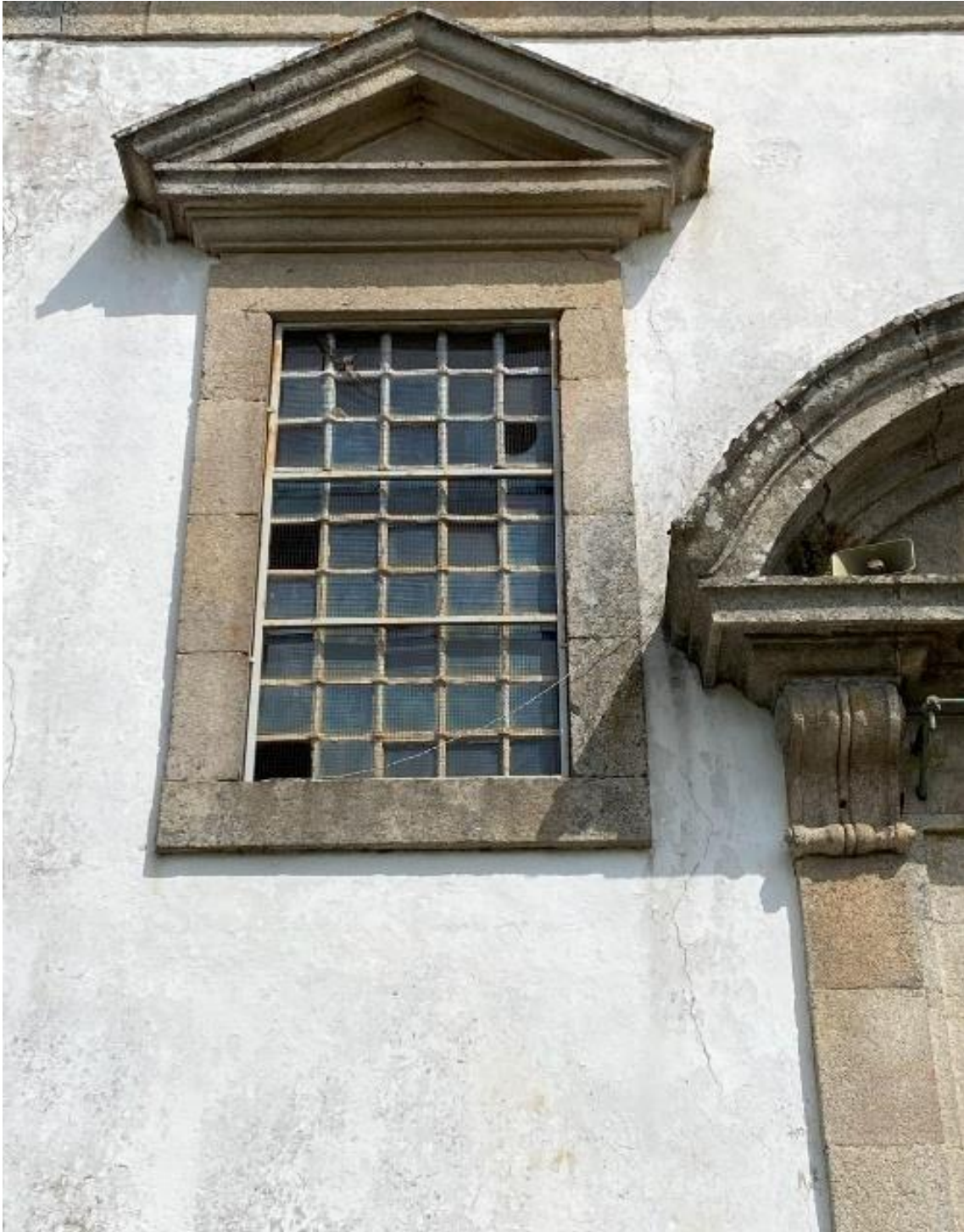
Fotografia 7 – Localização: Alçado Principal
