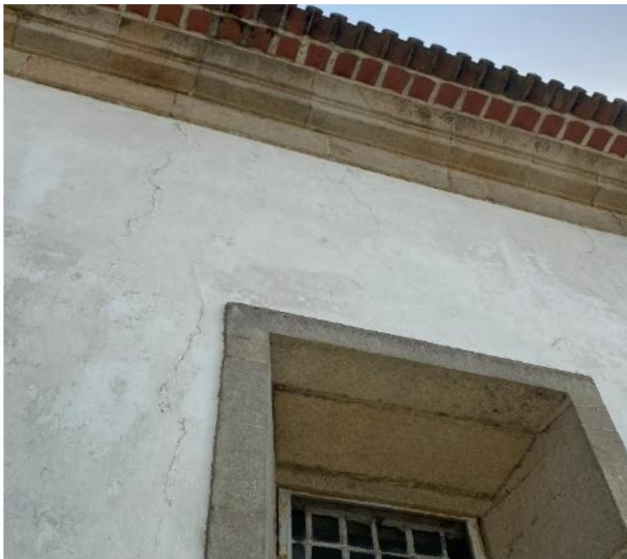
Fotografia 43 – Localização: Alçado Lateral Esquerdo
