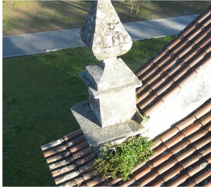
Figura 82 –Exemplo selecionado para ilustrar uma colonização biológica
