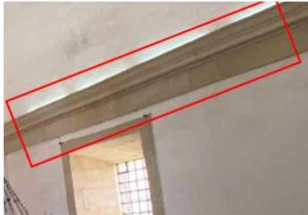
Figura 56 – Vista do friso e da cornija das paredes internas
