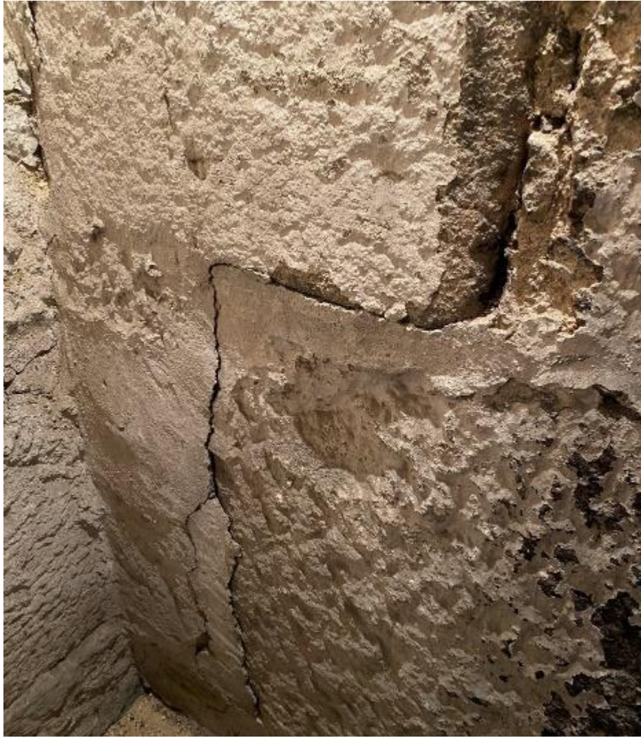
Fotografia 68 – Localização: Escada de Acesso ao Piso Intermédio sobre a Sacristia
