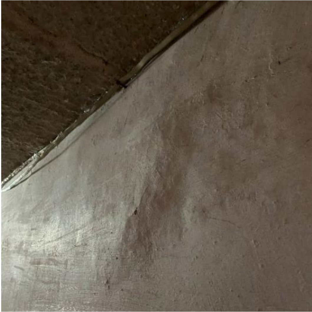
Fotografia 38 – Localização: Parede Lateral Esquerda (interna) do Corredor de Acesso à Sacristia
