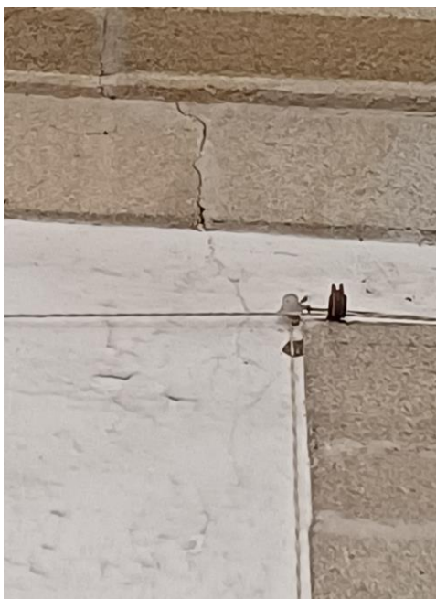
Fotografia 40 – Localização: Parede Lateral Esquerda (interna)
