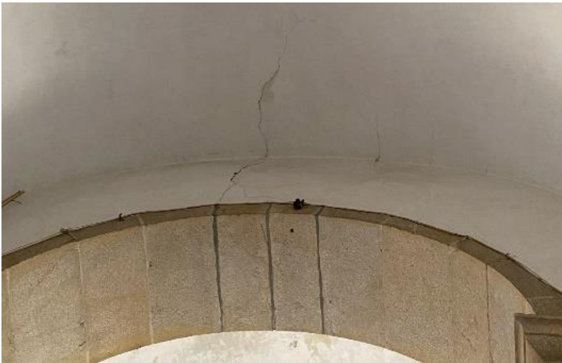
Fotografia 27 – Localização: Parede do Arco Principal (face da Capela-mor)
