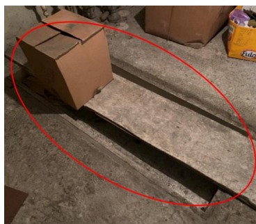
a) Abertura retangular no pavimento sobre a sacristia
