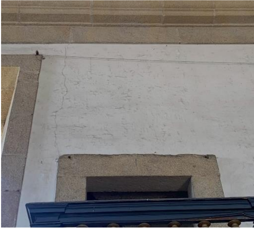
Fotografia 34 – Localização: Parede Lateral Esquerda (interna) da Nave
