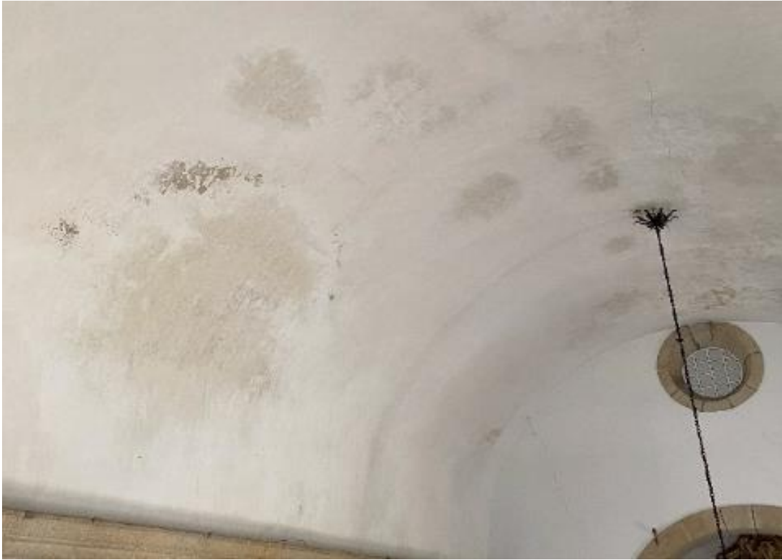
Fotografia 81 – Localização: Forro da Cobertura da Nave
