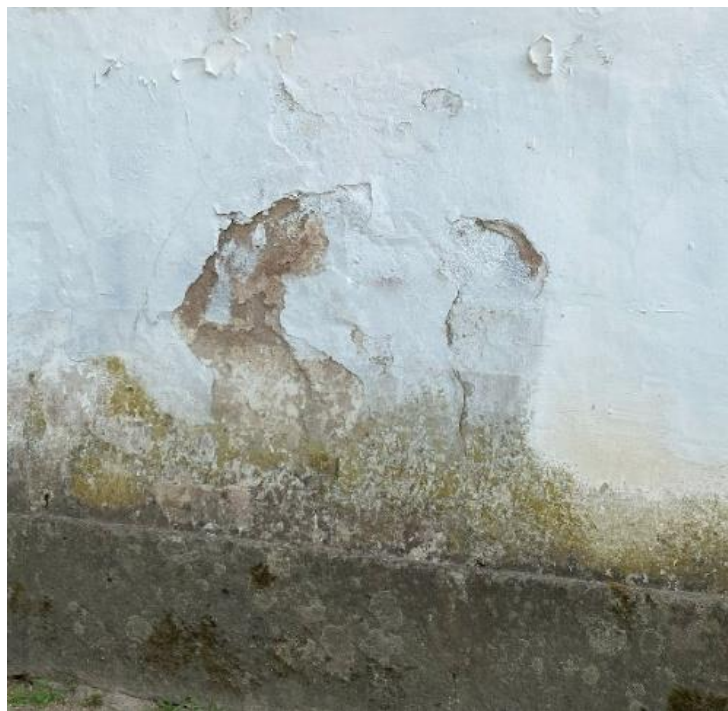
Fotografia 46 – Localização: Alçado Lateral Esquerdo
