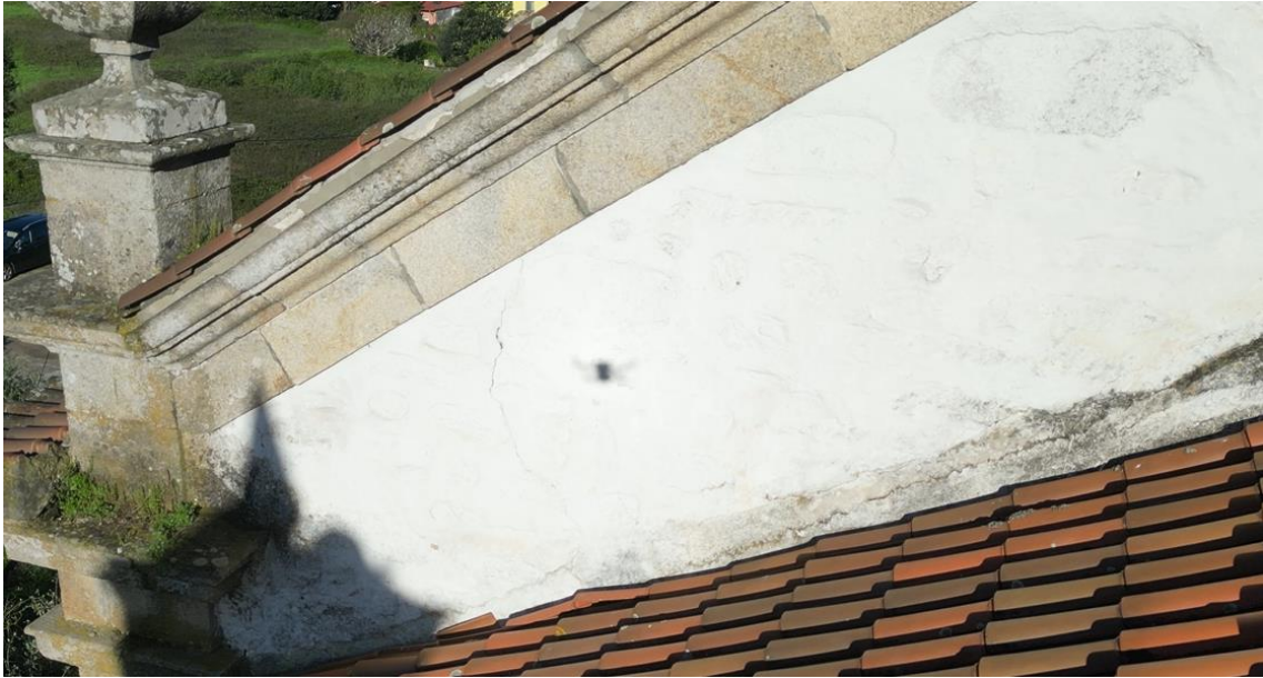
Fotografia 28 – Localização: Parede do Arco Principal acima da Cobertura
