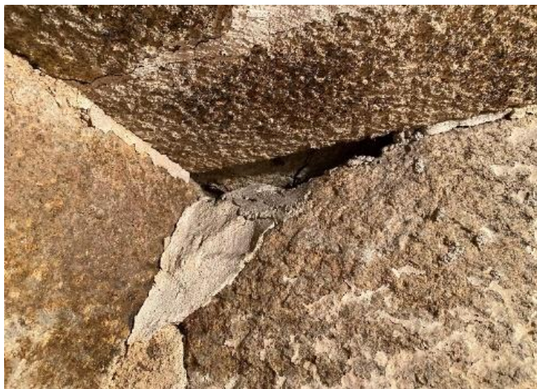
Fotografia 69 – Localização: Escada de Acesso ao Piso Intermédio sobre a Sacristia
