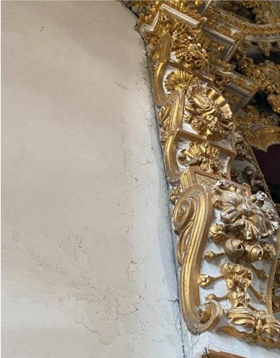
Fotografia 54 – Localização: Parede Interna ao Fundo da Capela-mor
