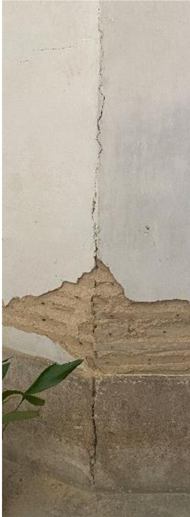
Fotografia 76 – Localização: Paredes de Tabique da Caixa de Escadas de Acesso ao Coro
