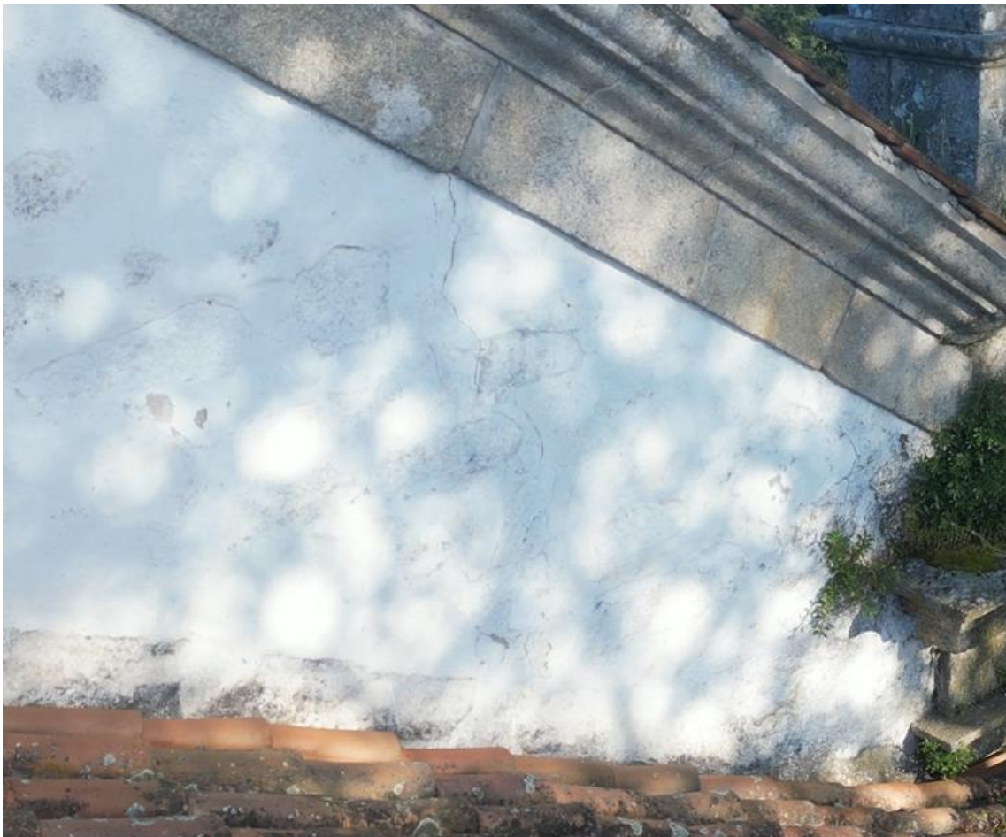
Fotografia 88 – Localização: Parede do Arco Principal acima da Cobertura
