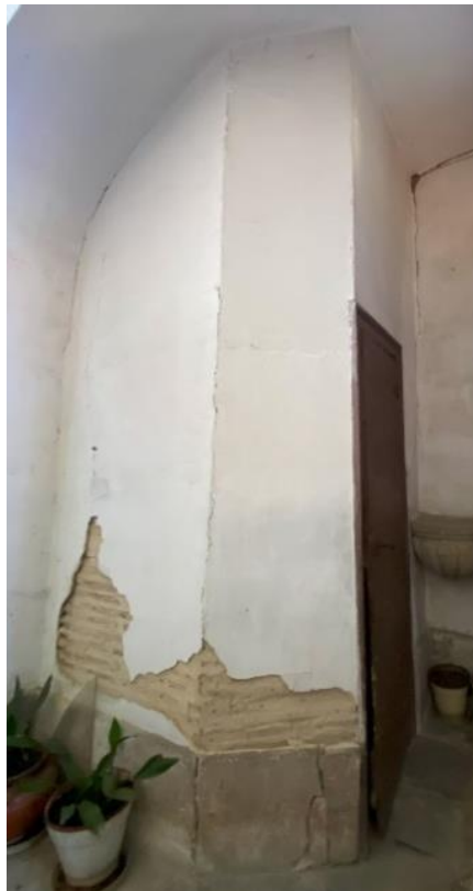
Figura 44 – Paredes de tabique que compõe a caixa de escadas
