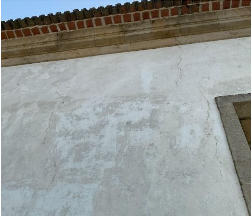
Fotografia 42 – Localização: Alçado Lateral Esquerdo
