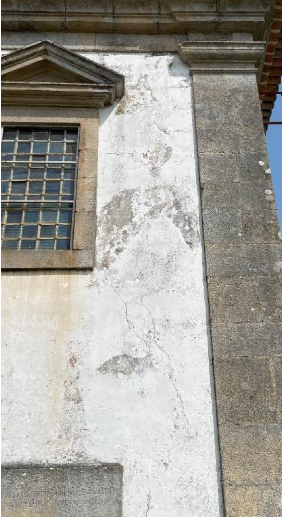
Fotografia 3 – Localização: Alçado Principal
