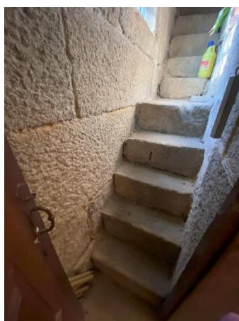
a) Arranque da escada
