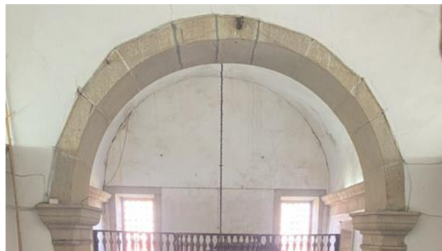
e) Arco principal de acesso à Capela-mor
