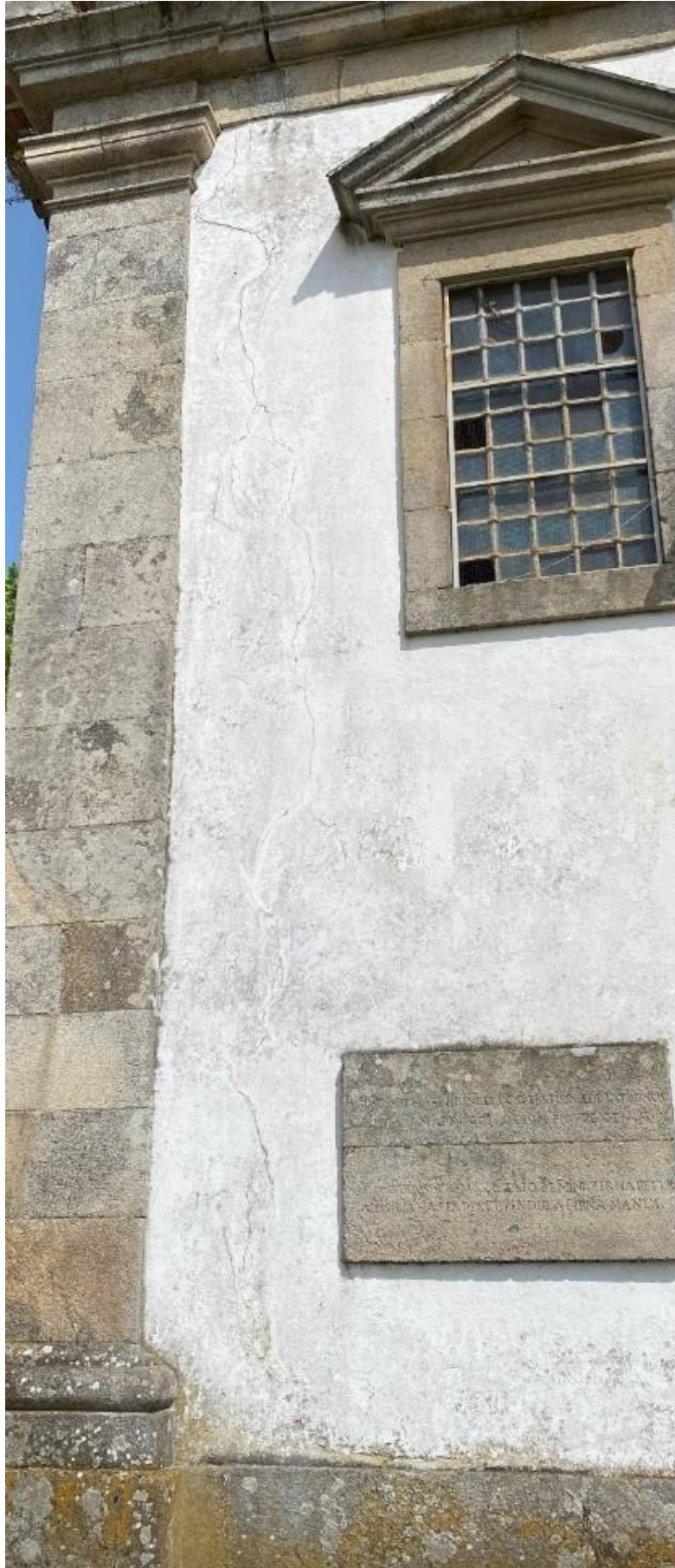
Fotografia 4 – Localização: Alçado Principal
