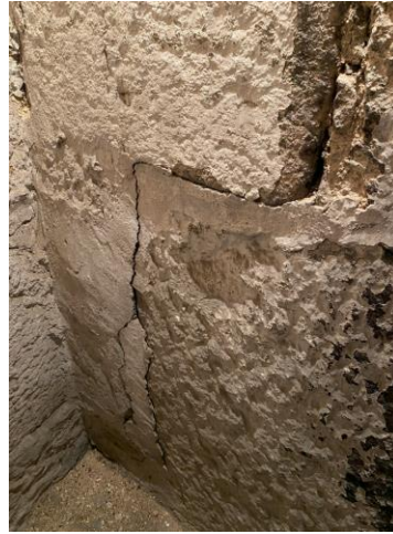
b) Parede lateral da escadaria da Sacristia
