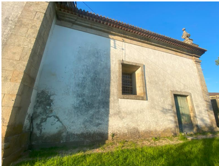
Figura 95 – Parte do Alçado Lateral Direito Exterior (zona da capela-mor e sacristia)
