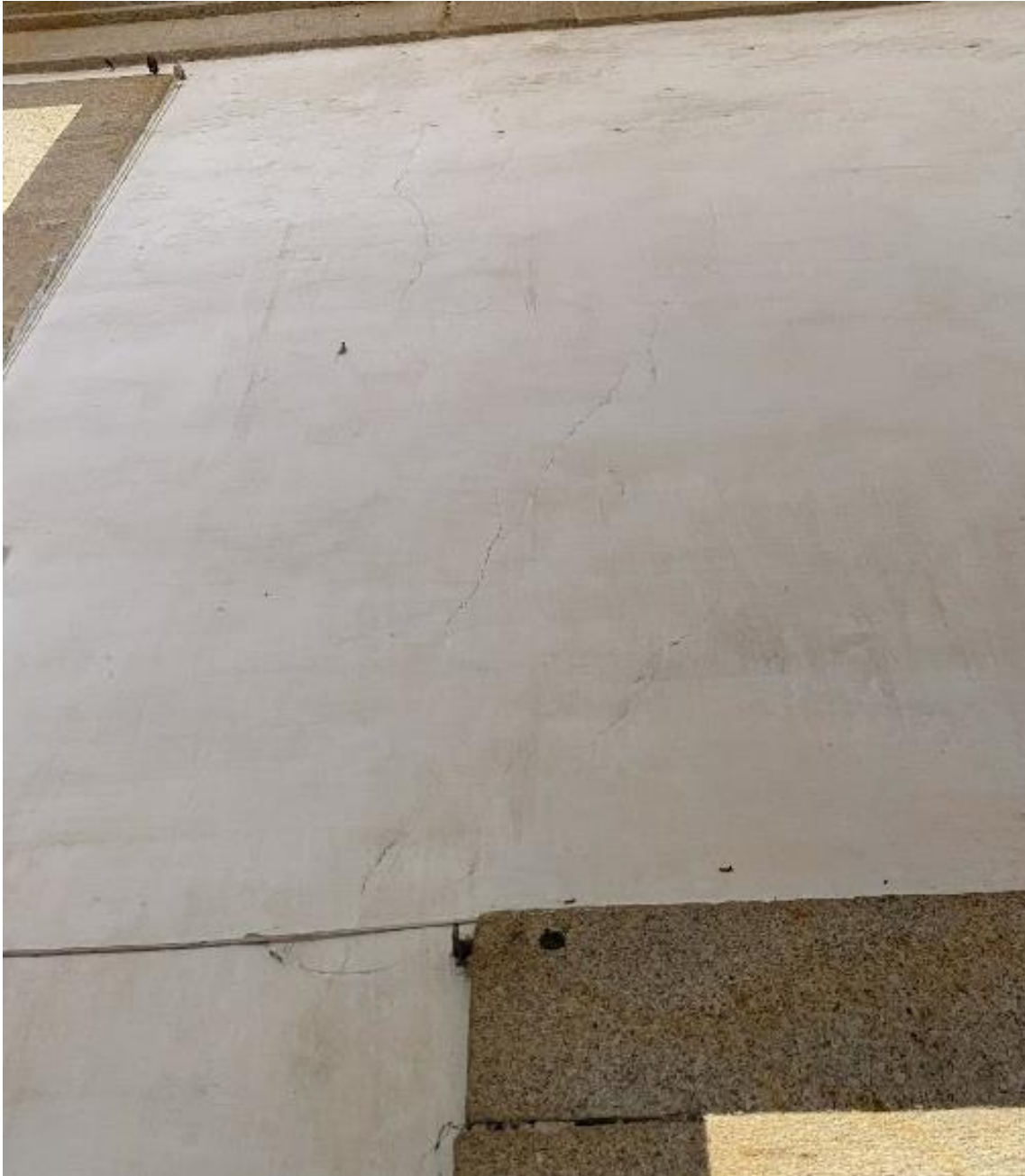
Fotografia 19 – Localização: Parede Lateral Direita (interna)
