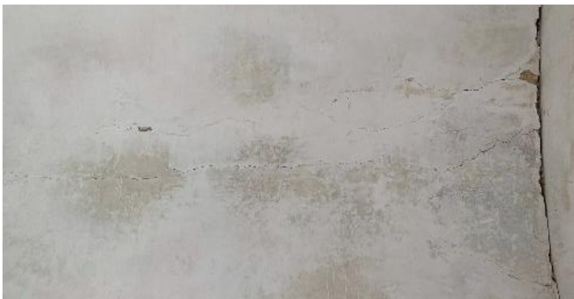
Fotografia 80 – Localização: Forro da Cobertura da Nave
