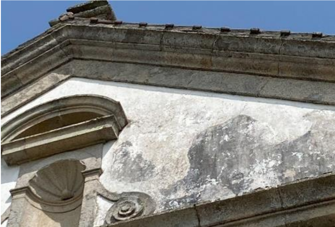
Fotografia 5 – Localização: Alçado Principal
