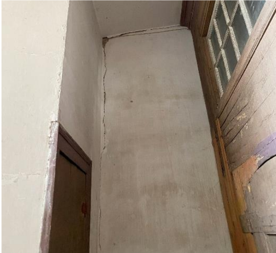
Fotografia 22 – Localização: Parede Frontal (interna) ao lado do Átrio da Entrada
