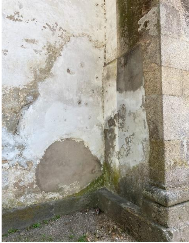
Fotografia 45 – Localização: Alçado Lateral Esquerdo
