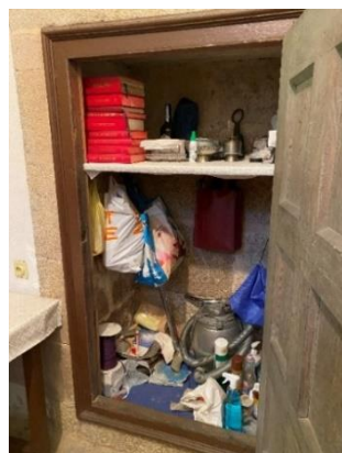
Figura 37 – Armário embutido na parede da sacristia
