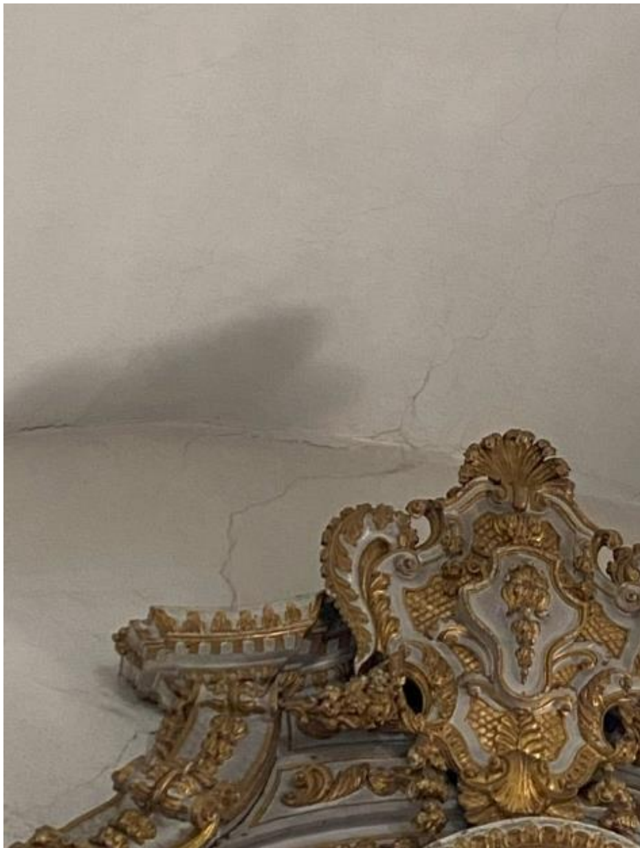
Fotografia 50 – Localização: Parede Interna ao Fundo da Capela-mor
