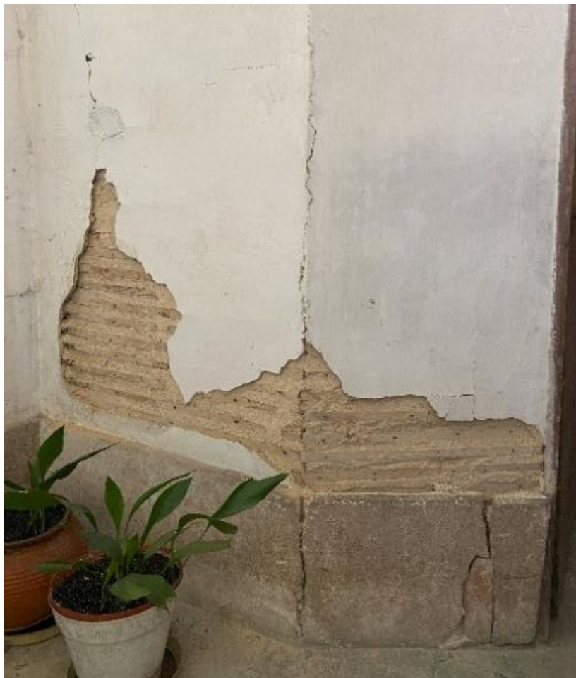
Fotografia 75 – Localização: Paredes de Tabique da Caixa de Escadas de Acesso ao Coro
