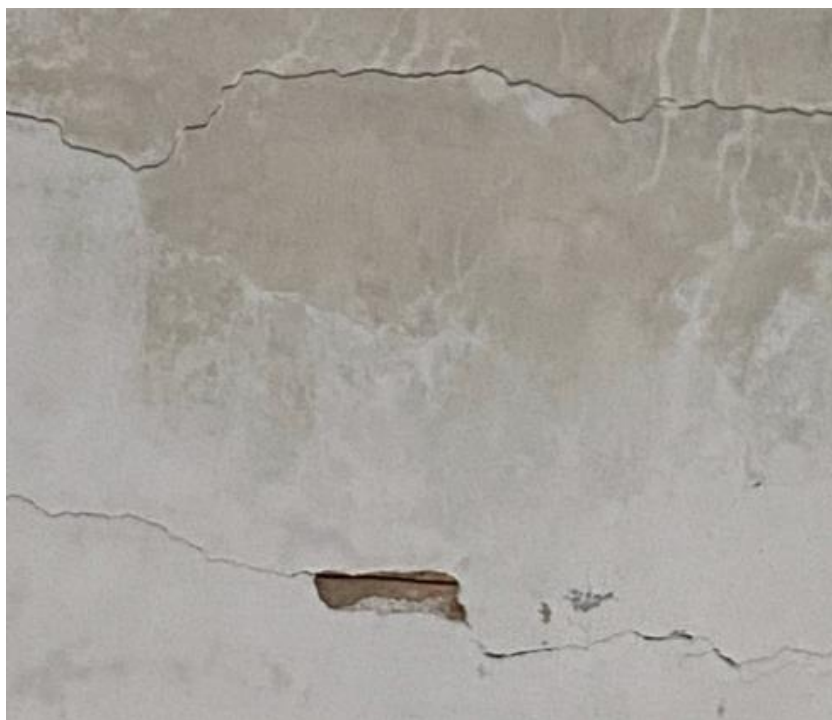
Fotografia 79 – Localização: Forro da Cobertura da Nave
