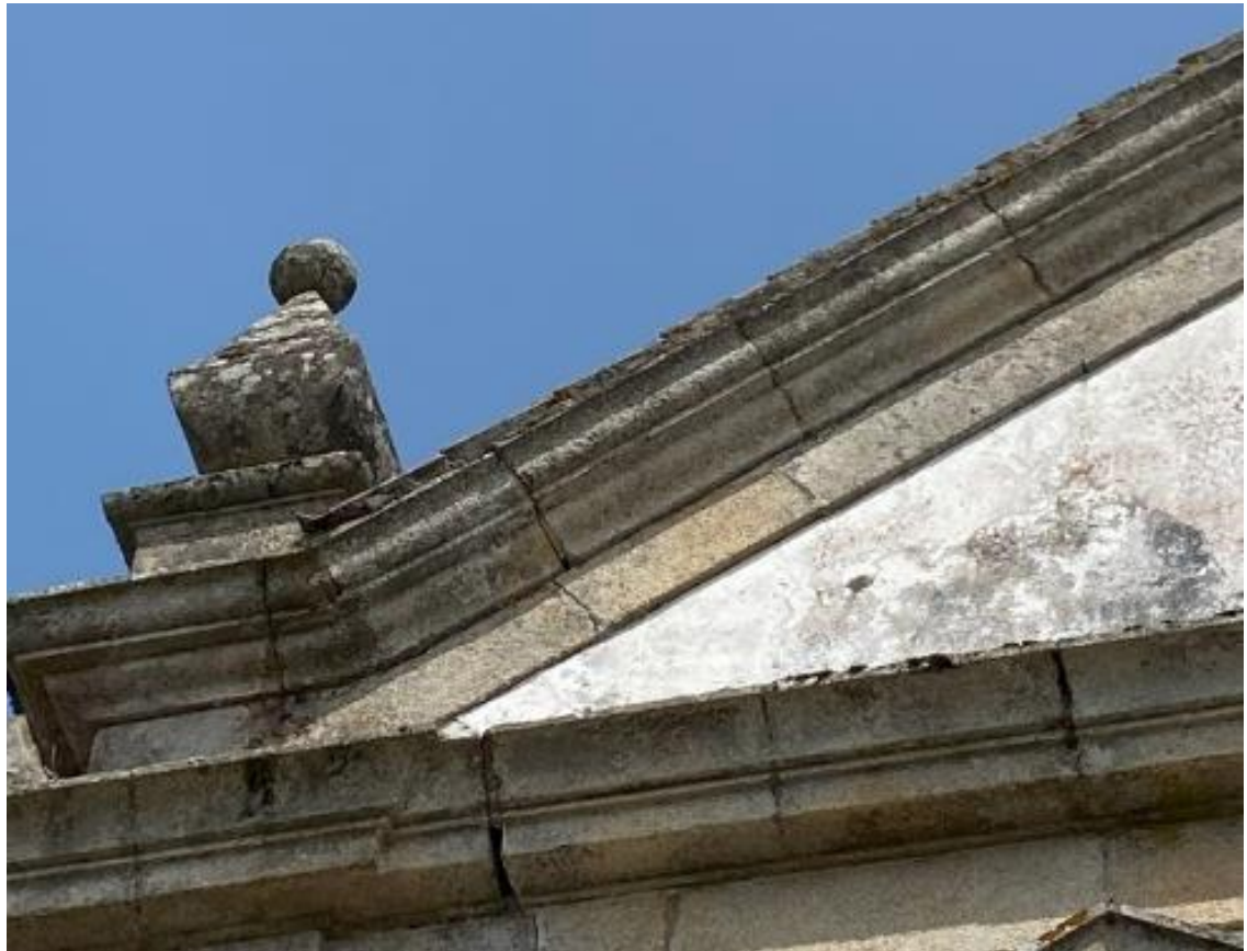
Fotografia 6 – Localização: Alçado Principal
