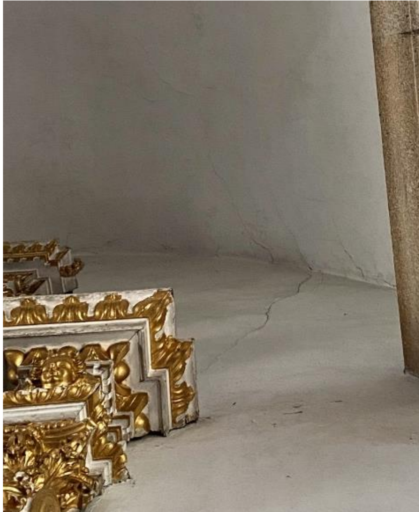
Fotografia 51 – Localização: Parede Interna ao Fundo da Capela-mor
