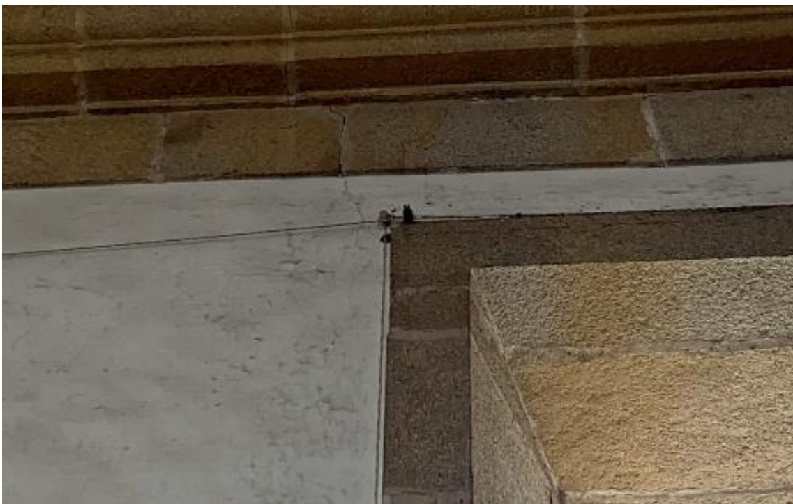
Fotografia 18 – Localização: Parede Lateral Direita (interna)
