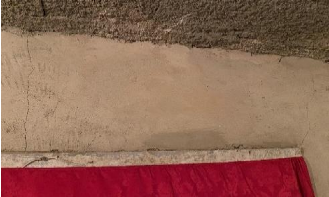
Fotografia 74 – Localização: Piso Intermédio sobre a Sacristia
