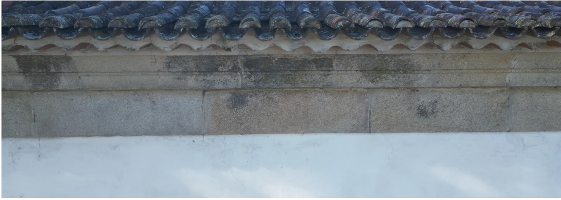
Fotografia 49 – Localização: Alçado Lateral Esquerdo
