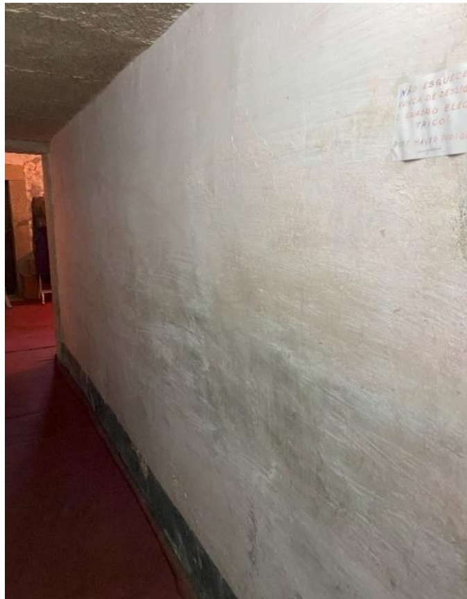
Fotografia 37 – Localização: Parede Lateral Esquerda (interna) do Corredor de Acesso à Sacristia
