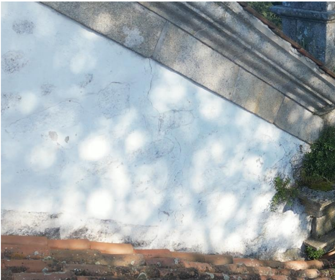
Fotografia 29 – Localização: Parede do Arco Principal acima da Cobertura
