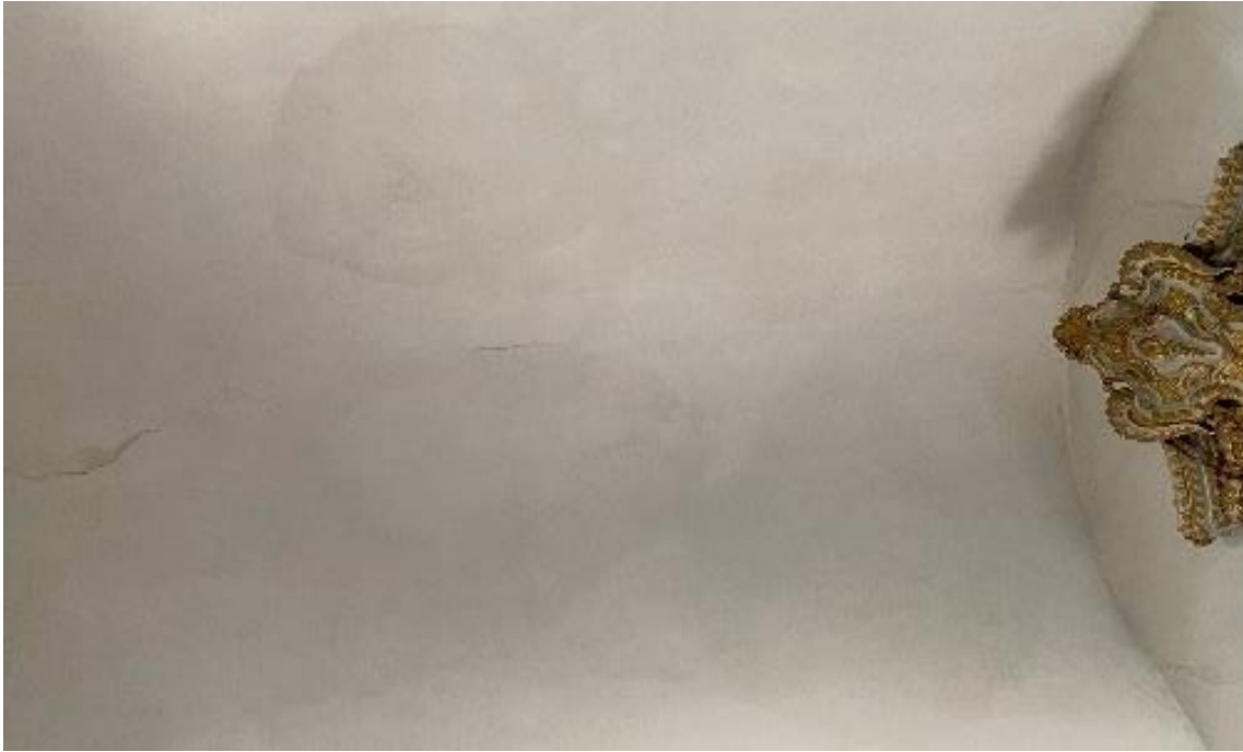
Fotografia 83 – Localização: Forro da Cobertura da Capela-mor
