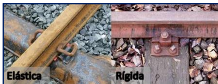
Figura 7 - Tipos de fixações.
