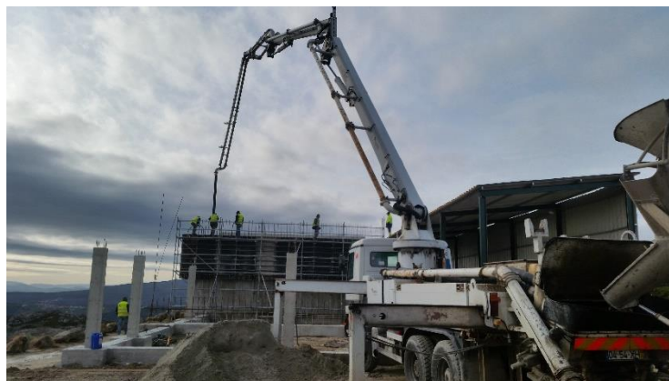
Figura 4-3 Entrega de Betão Pronto Realizado pela Granbeira S.A.
