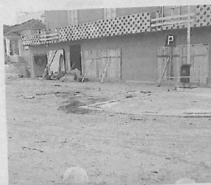
RESTAURANTES defendem entradas e janelas com placas de madeira
