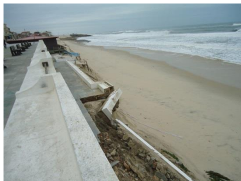
Antes da intervenção de emergência.
