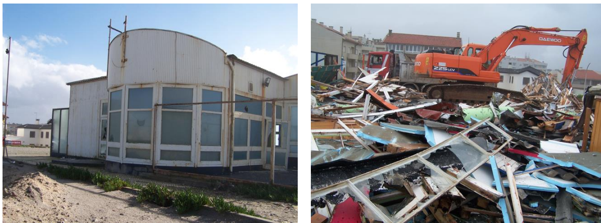
Ilustração 2 -Equipamento da Junta de freguesia de Esmoriz e a sua demolição, 2006.
