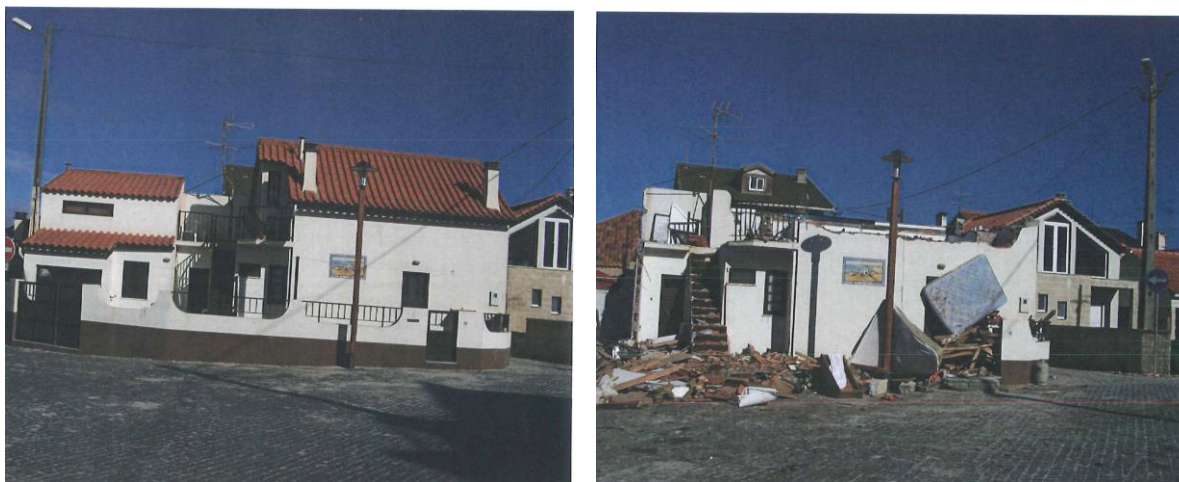
Ilustração 4 - Habitação clandestina em DPM e sua demolição, 2007
