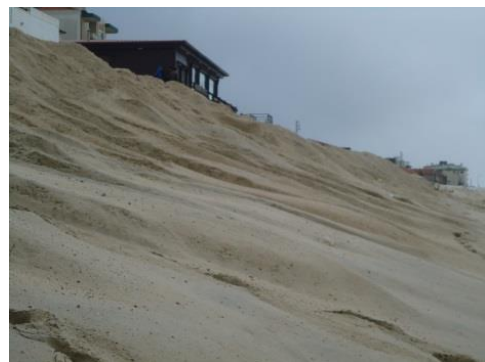
Depois da intervenção de emergência.
