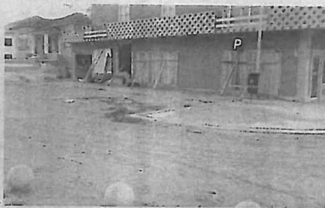
O MAR provocou, recentemente, diversos estragos
