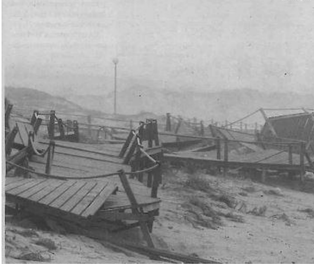
Estragos das investidas do mar provocaram elevados prejuízos
