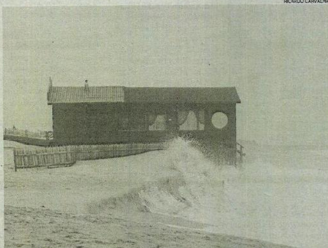
A "Casa Dumar" voltou, ontem à tarde, a ser atingida pelo mar, fragilizando ainda mais a estrutura.
