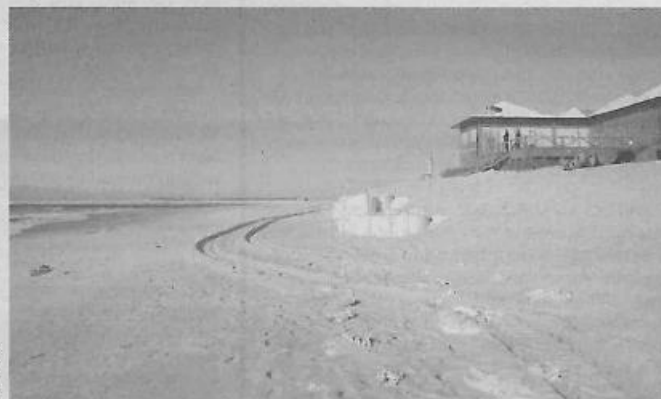
SACOS DE AREIA à vista, que deviam estar enterrados, mostram que a erosão continua
