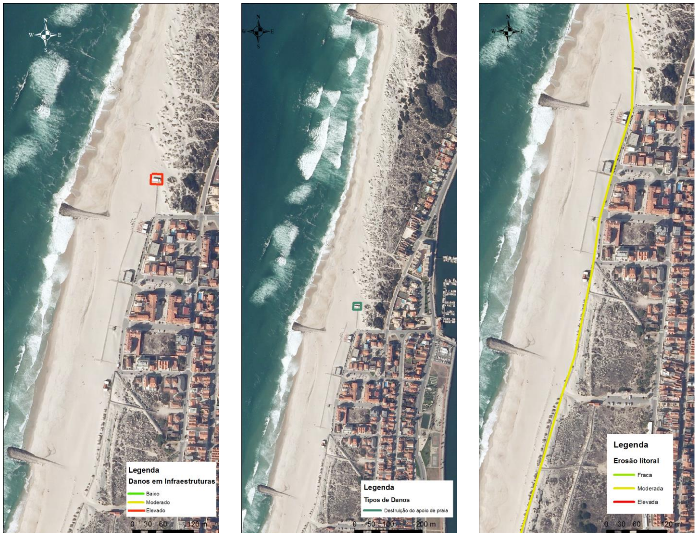
Figura 9- Caracterização dos danos e susceptibilidade à erosão litoral na praia da Costa Nova do Prado.
