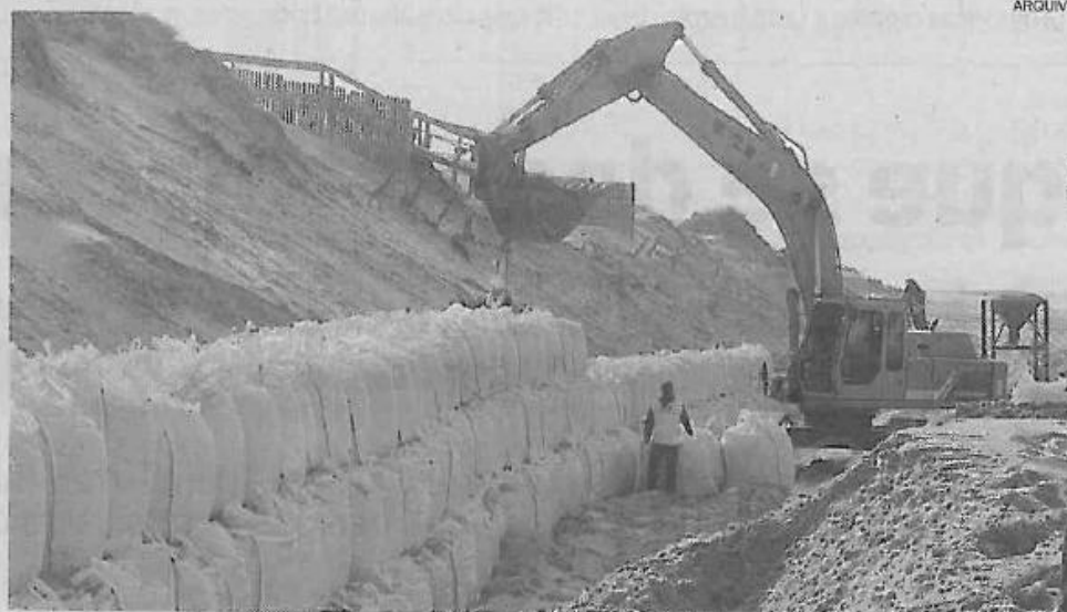
Dunas Ponte no Poço da Cruz surge na sequência do reforço do cordão dunar da Praia de Mira
