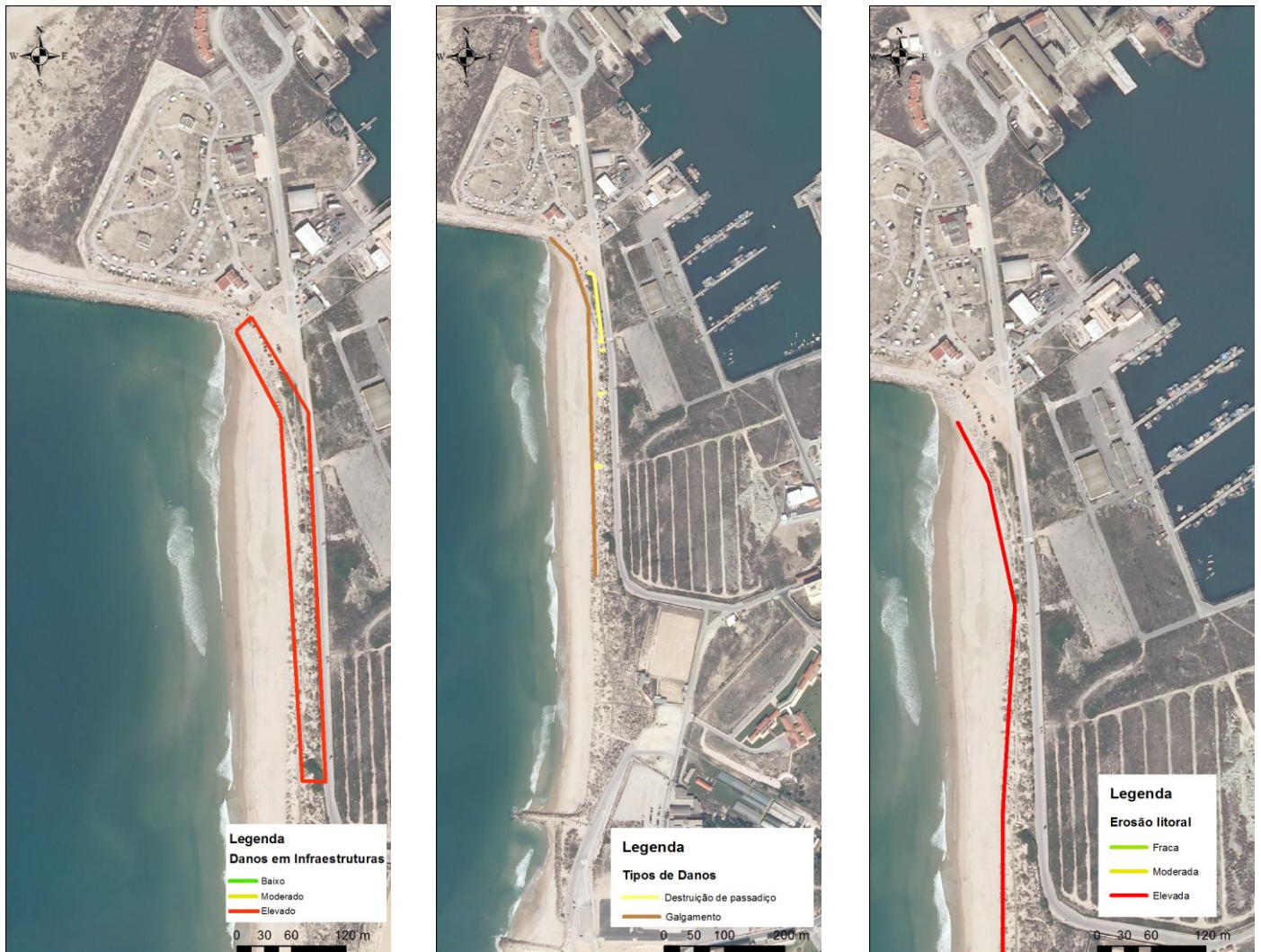
Figura 16- Caracterização dos danos e susceptibilidade à erosão litoral na praia do Cabedelo (área portuária).
