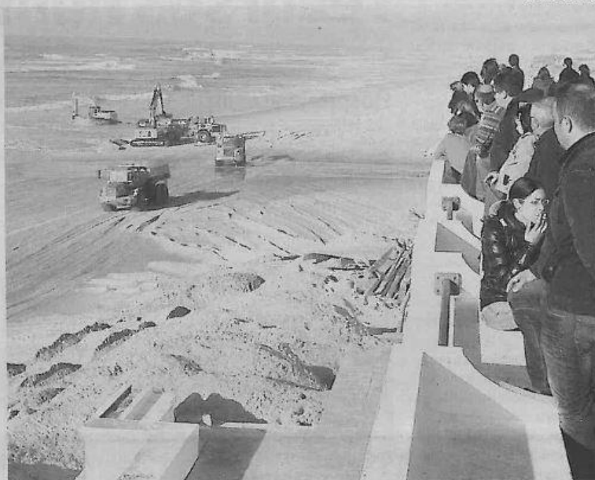
Máquinas colocaram 15 mil metros cúbicos de areia para proteger paredão
