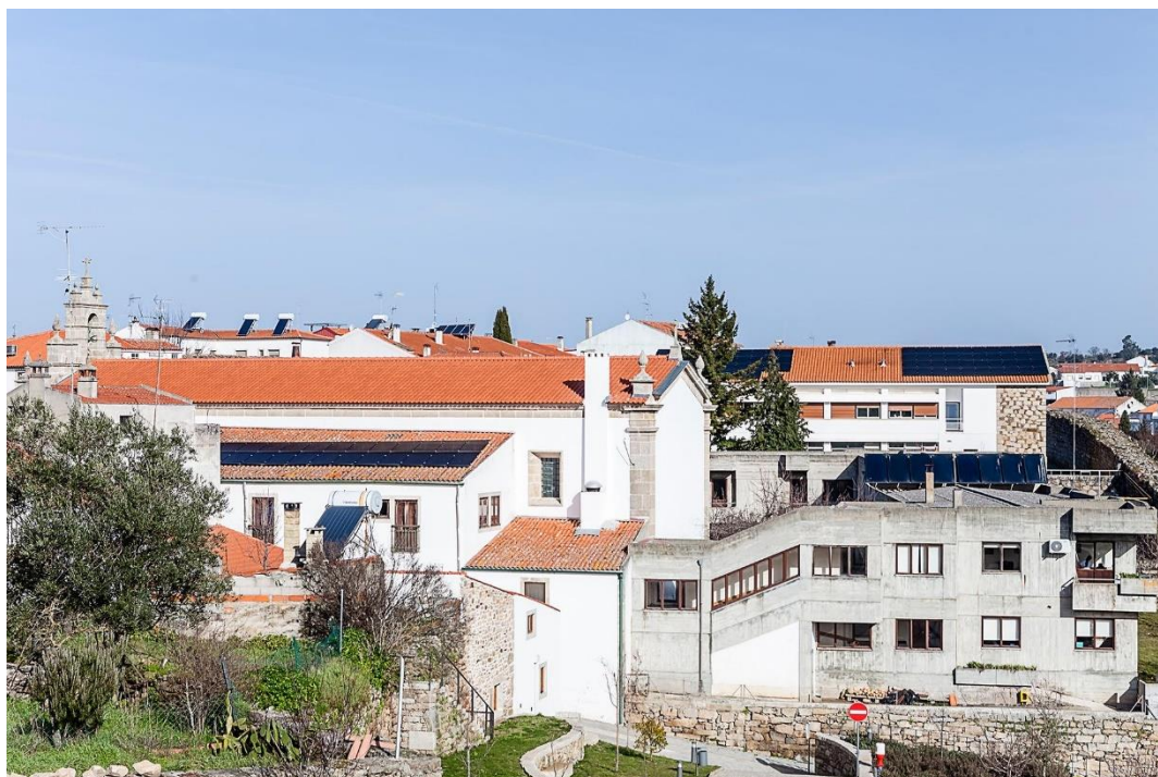
Figura 4 - Módulos Fotovoltaicos Instalados na CER de Miranda do Douro (Fonte: [22])
