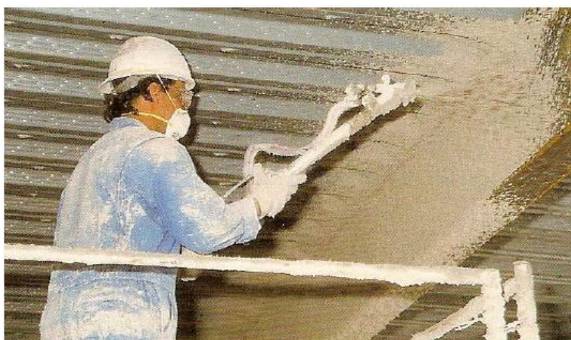
Figura 2-7: Argamassa projetada (Gérken, 2007)
