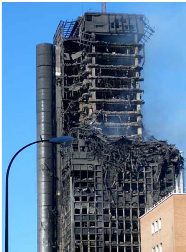
Figura 1-1: Torre Windsor após incêndio (Mesquita, 2013)
