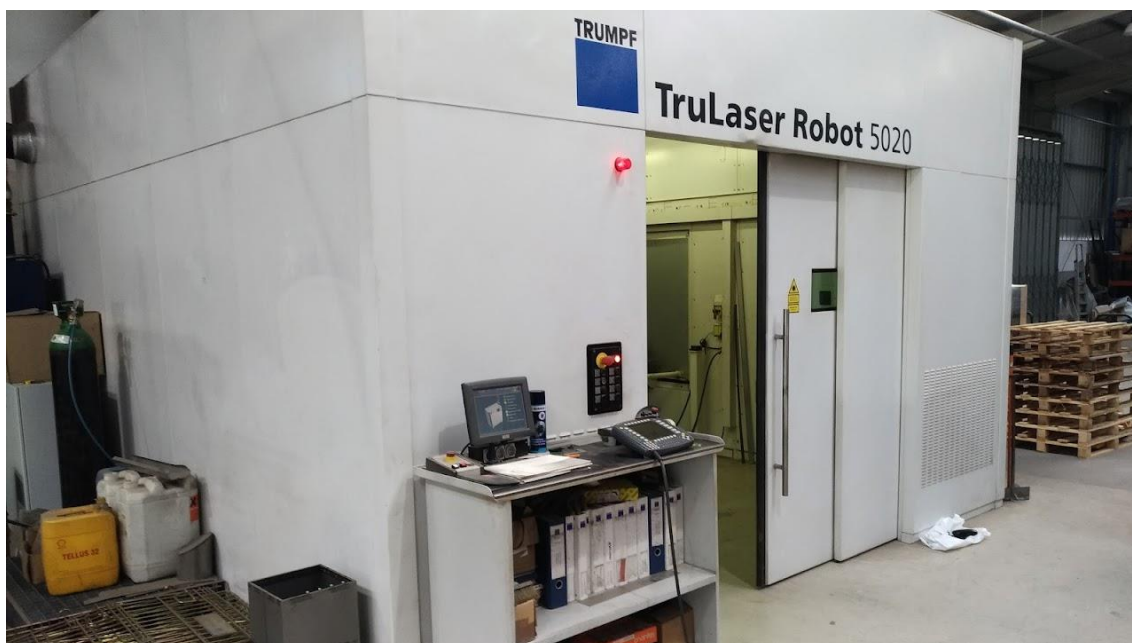
Figura 36 - Célula de Soldadura TruLaser Robot 5020.
