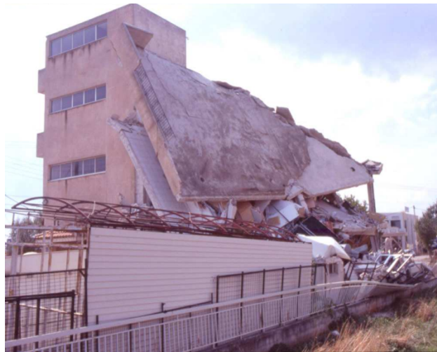
Figura 5-1: Colapso de edifício irregular em planta (Carvalho, 2008)
