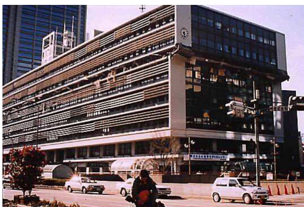
Figura 5-6: Colapso de edifício irregular em altura (Carvalho, 2008)
