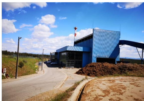
Figura 10 – Central Termoelétrica De Mortágua
