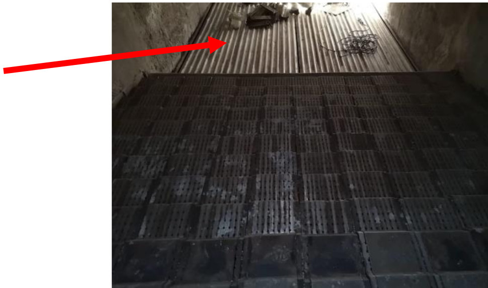
Figura 33 - Localização do sistema de vibração de grelha
