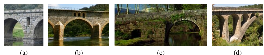
Figura 2-6: Pormenor de olhais: (a) sobre os pilares na ponte de Vila Formosa. Extraída de (Portugal, Alentejo); (b) sobre os arcos na ponte de Remondes. Extraída de (Portugal, trasosmontesnet); e (c) sobre encontros na ponte de Estorãos. Extraída de (Flickr). (d) Exemplo de aligeiramento dos muros de tímpano na ponte de Drizes. Extraída de (Portugal, Retratos e Recantos)
