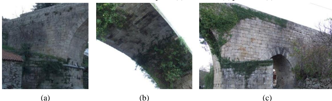
Figura F-9: D8.1 e D8.3 no alçado montante no: (a) EC1 , no MT , nas G e nos muros confinantes; (b) intradorso do A1 e (c) extradorso do A1 , no MT , no T e nas G
