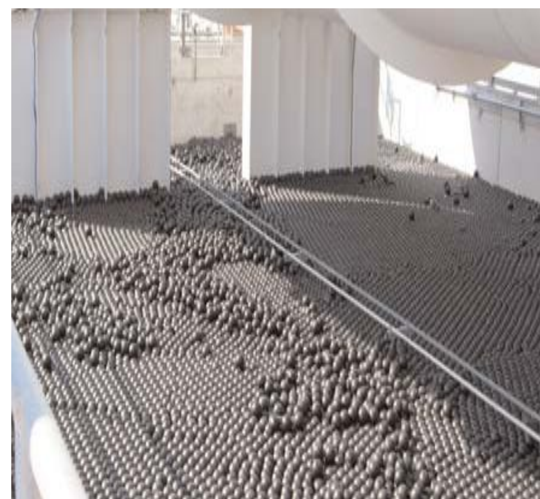
Figura 1 – Aspecto da cobertura com esferas de termoplástico de um tanque industrial.
