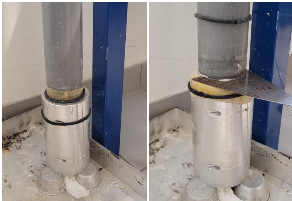
Figura 58 - Remoção do tubo de PVC do PROV4
