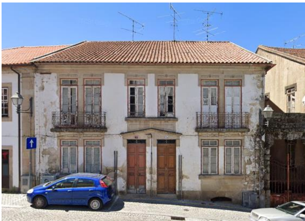
Figura 11 – Fachada do edifício.
