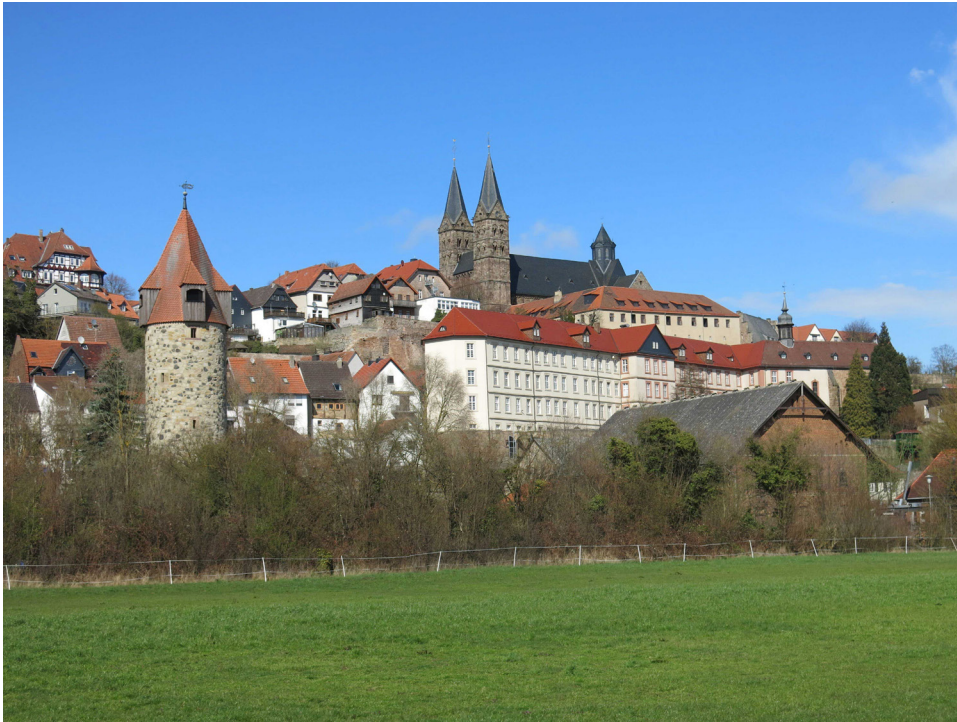
Fig. 3 – Sous-titre : Fritzlár, vue de la ville avec ‘Dom’ et l’église Sainte Catherine (à droite avec une petite tour). Ce bâtiment servit autrefois comme chapelle de l’ancien hôpital Sainte-Marie et du monastère des Augustiniennes et fut utilisé par les paroissiens de la Neustadt (photo prise à proximité du site de l’ancien hôpital du Saint-Esprit), photo : Gisela Naegle, 2021.
