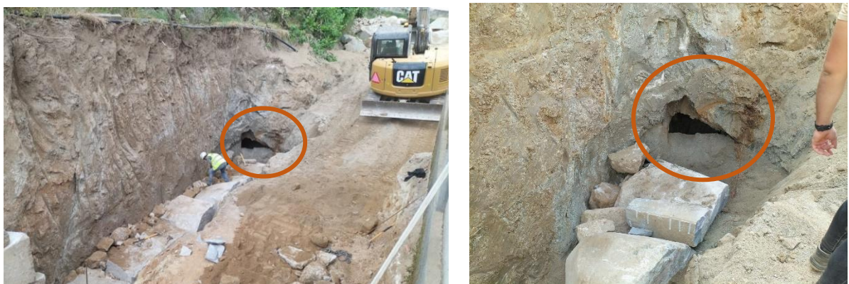
Figura 23 – Mina de água encontrada durante a escavação
