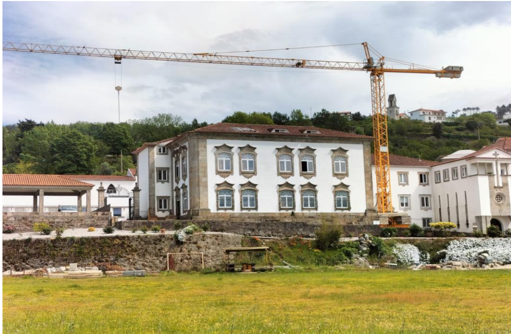
Figura 9 – Vista parcial sobre o edifício do Seminário (entrada principal)
