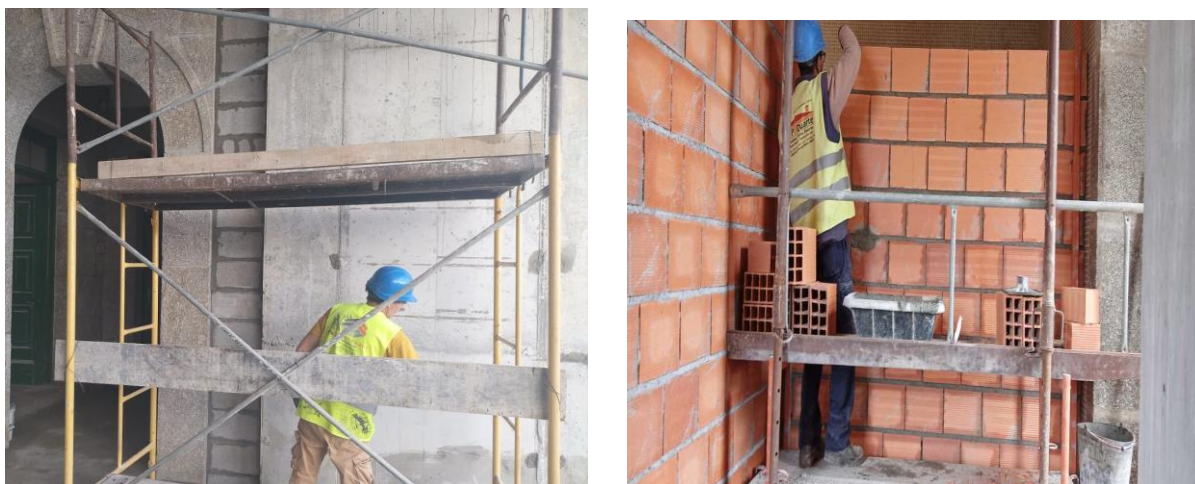
Figura 21 – Trabalhador sobre um andaime modular (andaime fixo, sem rodas)
