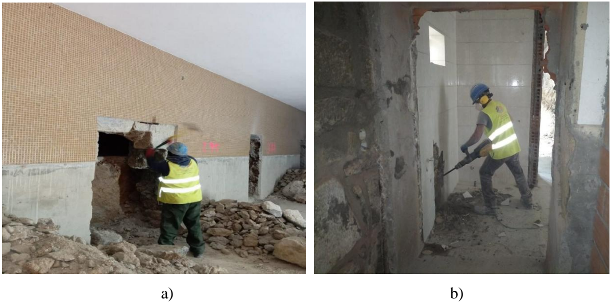
Figura 16 – a) Demolição manual na empreitada em estudo; b) Demolição mecânica
