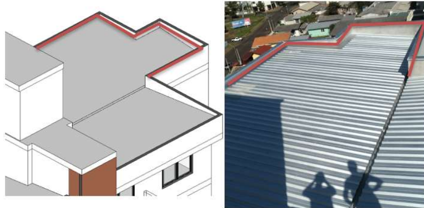
Figura 35 – Cobertura em chapa metálica
