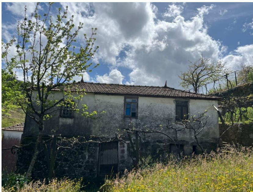
Figura 4 - Casa próxima do Moinho
