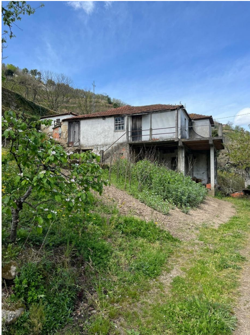
Figura 6 - Casa situada nas imediações do Moinho
