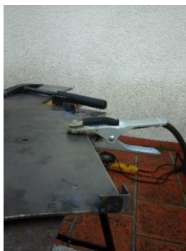
Figura 74. Manufatura dos batentes de ferro
