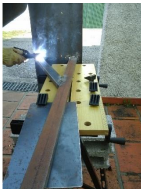
Figura 57. Processo de soldadura da escora de reforço
