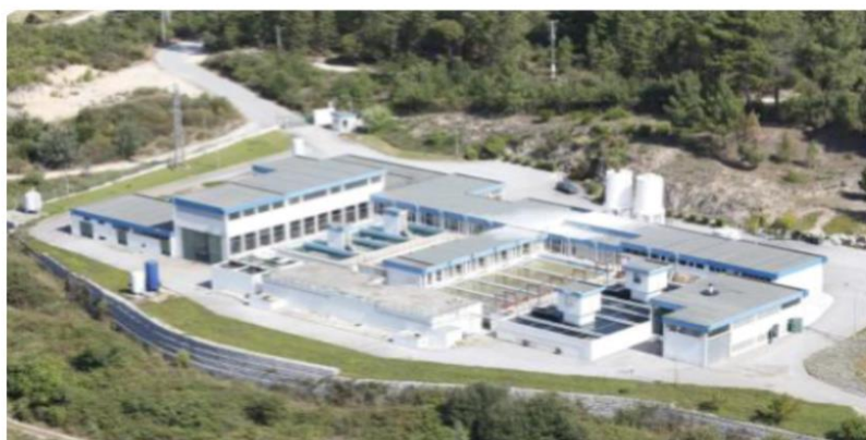
Figura 20-5: ETA de Fagilde
