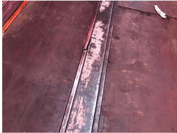
Figura 31 - Chão do camião danificado
