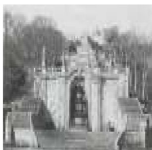
Figura 3.7 – Escadório construído até à Fonte do Pelicano
