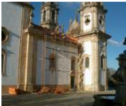
Figura 3.10 – Obras no telhado (2004)
