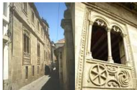
Figura 5.9 - Pormenor - janela da Casa do Poço (Rua dos Loureiros)
