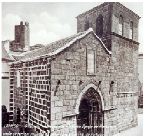
Figura 3.18 – Fachada com escadas soterradas
