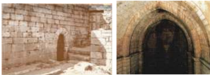
Figura 3.32 – Entrada e interior da cisterna
