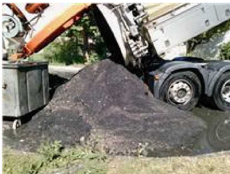
Figura 6.2: Exemplo de uma descarga de areias em local desapropriado e em contentor inadequado.
