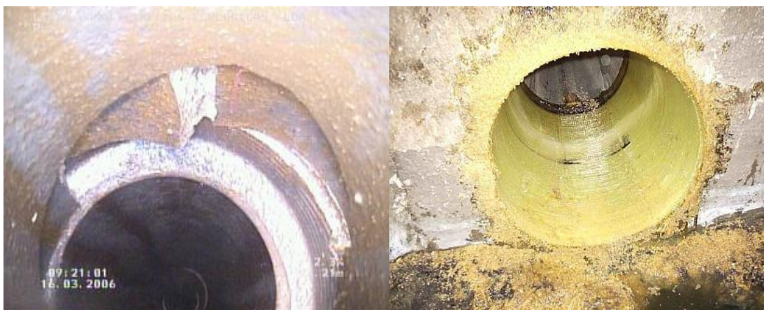
Figura 5.6: Fotografia representativa de um dano de um coletor e o seu aspeto posteriormente à respetiva reabilitação.
