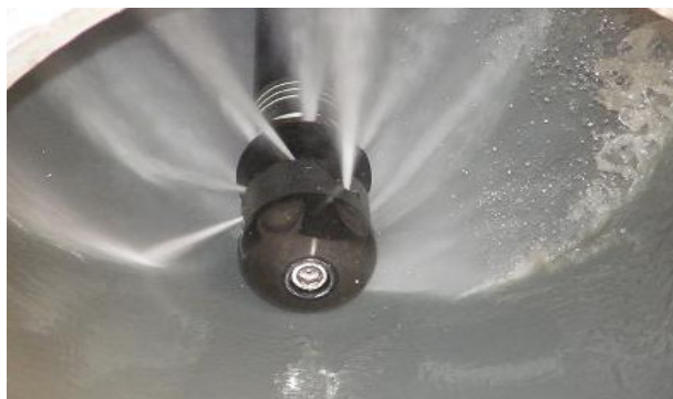
Figura 2.1: Fotografia ilustrativa da forma da limpeza dos coletores.
