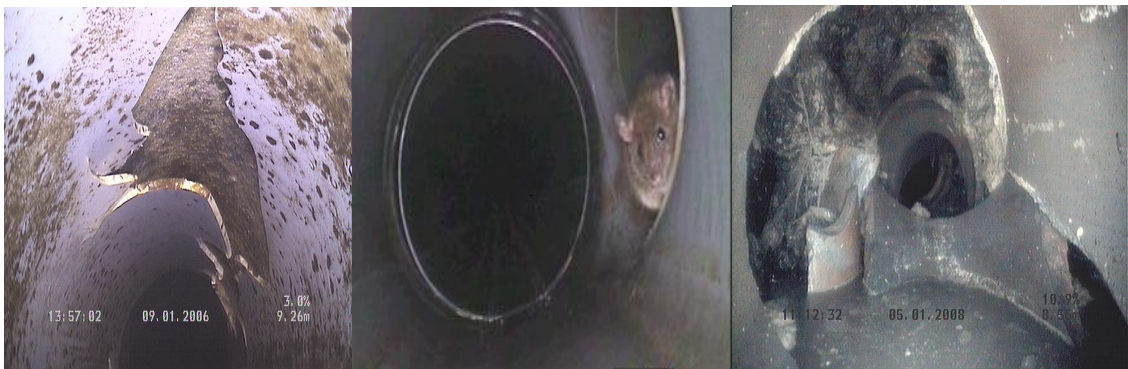
Figura 2.2: Fotografias ilustrativas de inspeção vídeo de coletores.
